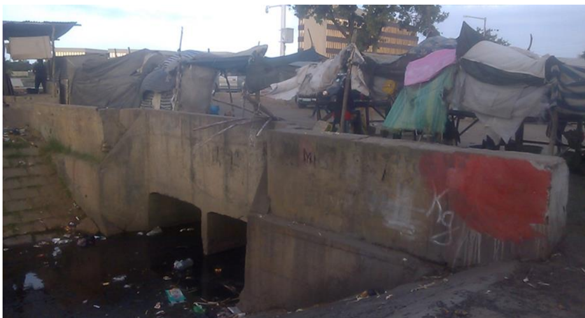
Figuras. 4.1. Bancas de venda de produtos alimentares montadas perto de valas de drenagem, com RS estagnados.
