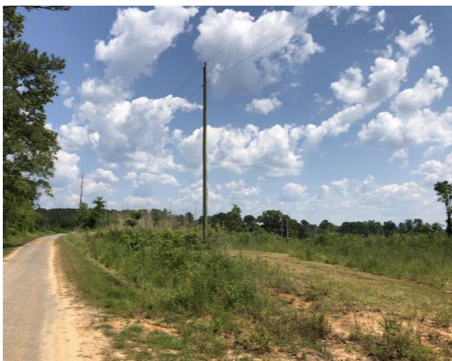
Figure 1: Poste de baixa tensão (autor)
