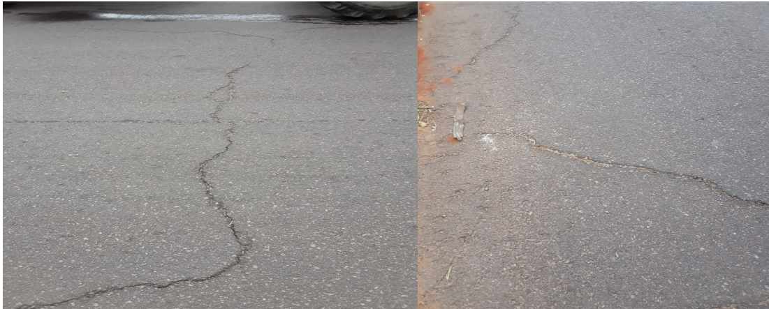
Figura 7- Representação de fendas transversais (estrada que liga ponte Alcantra)
