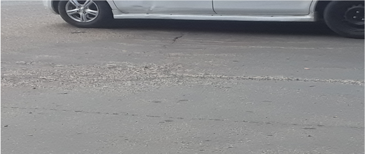
Figura 3- Representação de um abatimento (fonte: foto tirada no Município de Maputo)
