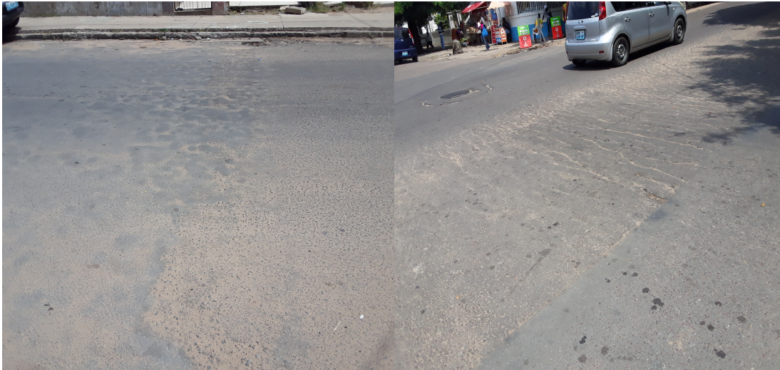
Figura 4- Representação da patologia do tipo ondulação (fonte: foto tirada do Município de Maputo)
