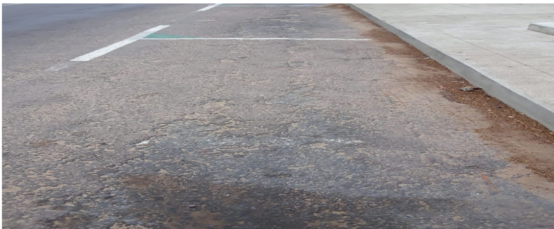
Figura 13- Representação da patologia do tipo exsudação (fonte: foto tirada do Município de Maputo)
