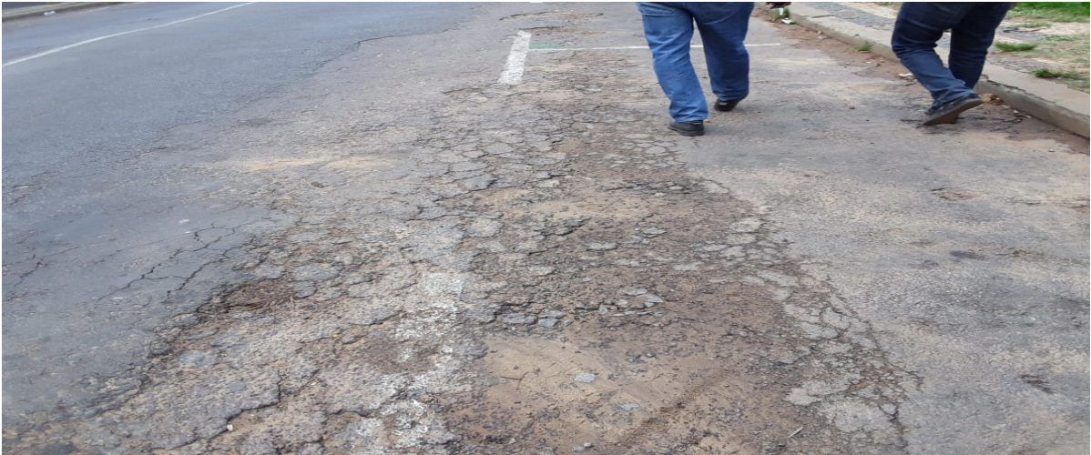
Figura 11- Representação da patologia tipo pelada
