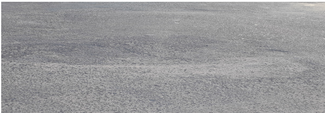
Figura 5- Representação da patologia do tipo Rodeira (fonte: foto tirada no Município de Maputo)
