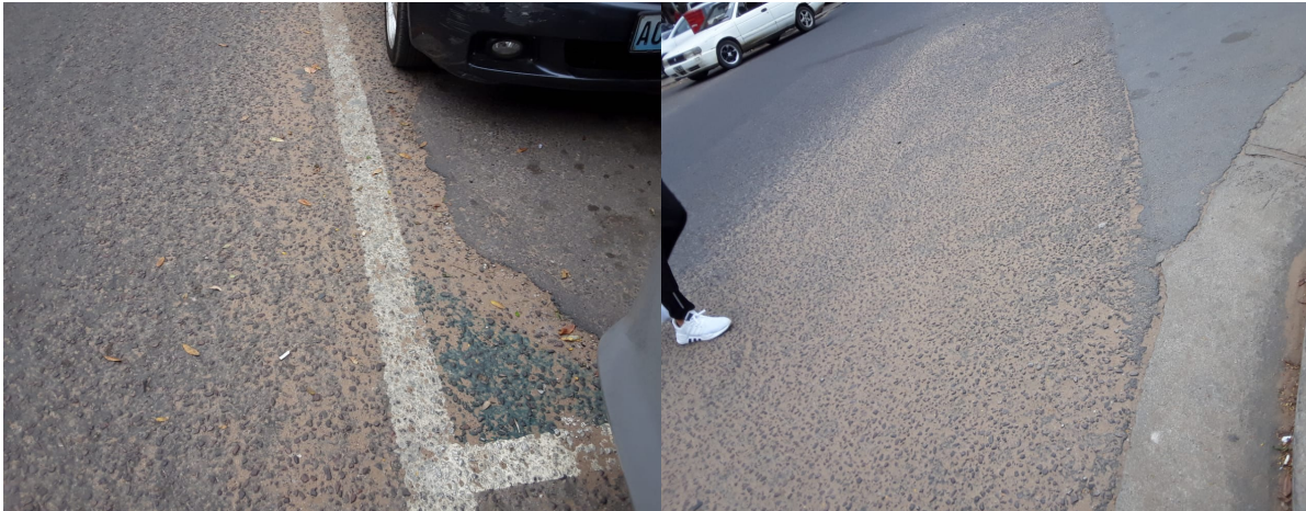
Figura 9- Representação da patologia tipo cabeça de gato (Av. Karl Max)
