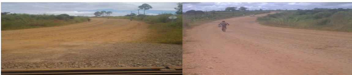
Figura 1.2: Passagem de nível entre a Cidade de Lichinga e o Distrito de Chimbunila. Fonte (Autor)
