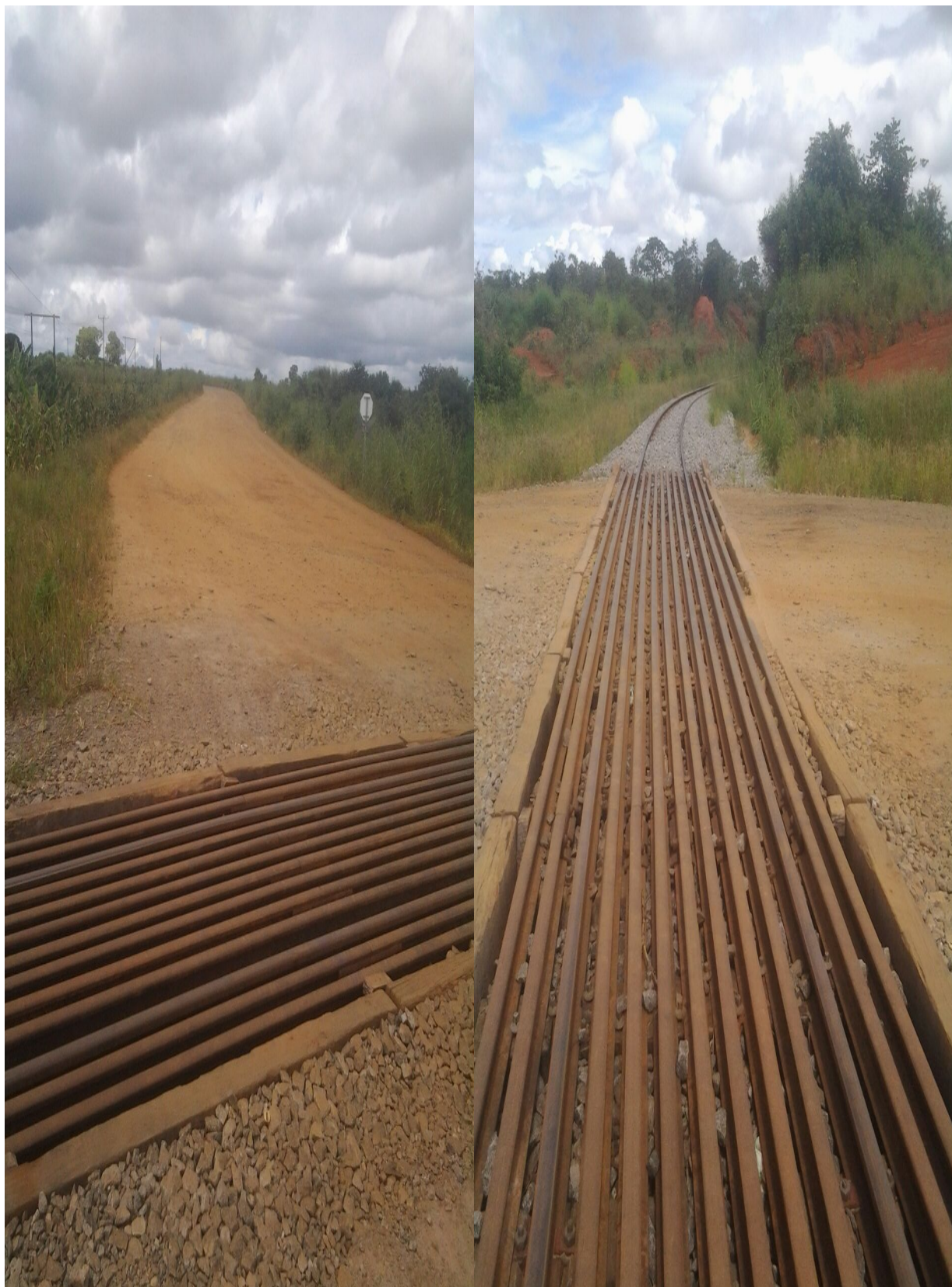
Figura e): Interseção da Rodovia Sudoeste e Ferrovia Figura f): Interseção e vista a zona de projecto ( vista Sul ) UEMFENG-2021
