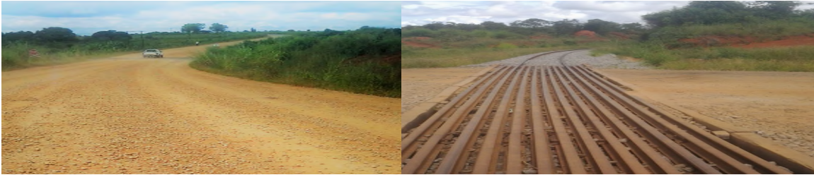
Figura 1.1: Passagem de nível entre a Cidade de Lichinga e o Distrito de Chimbunila. Fonte (Autor)
