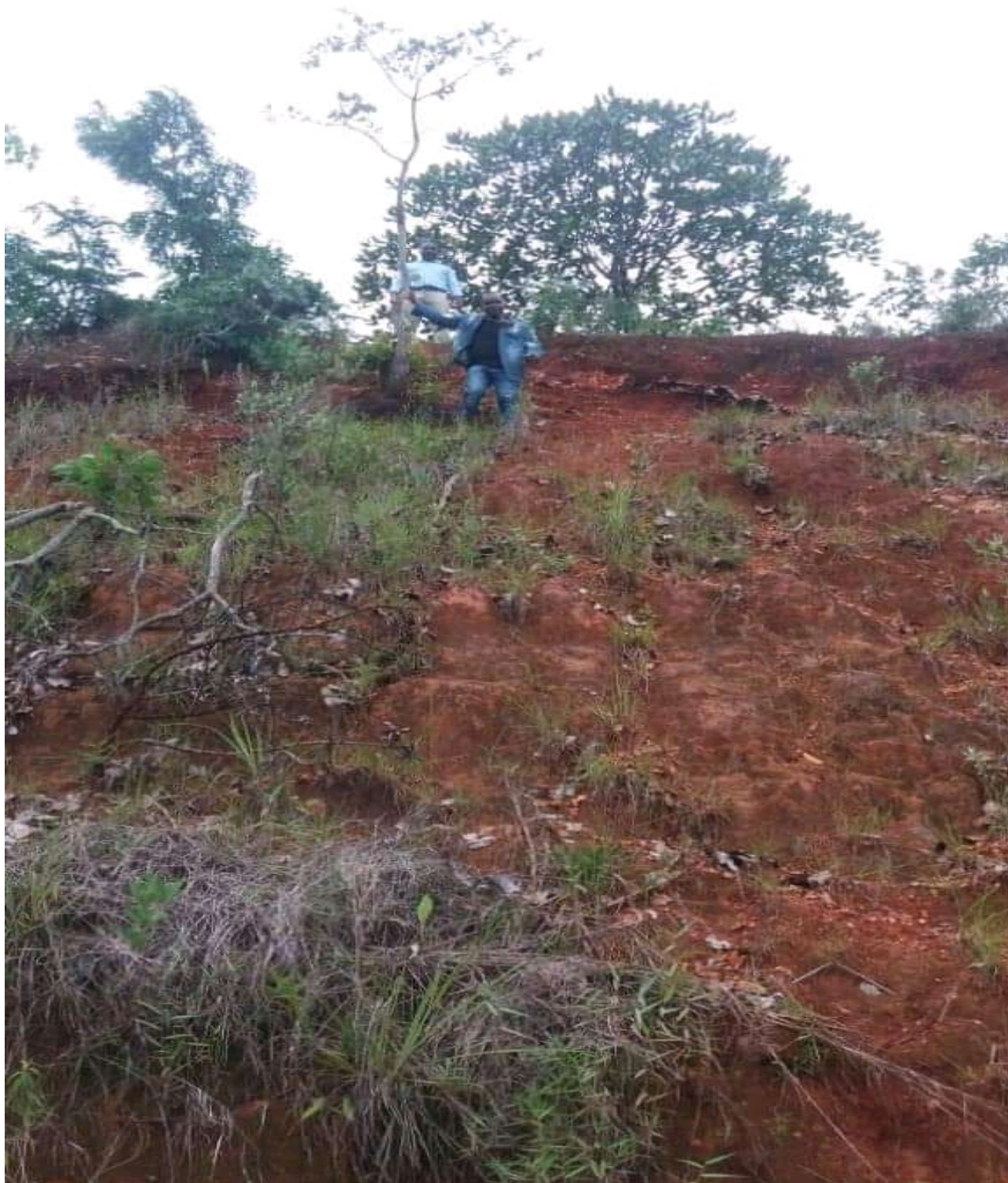
Figura d): Imagem do talude Noroeste
