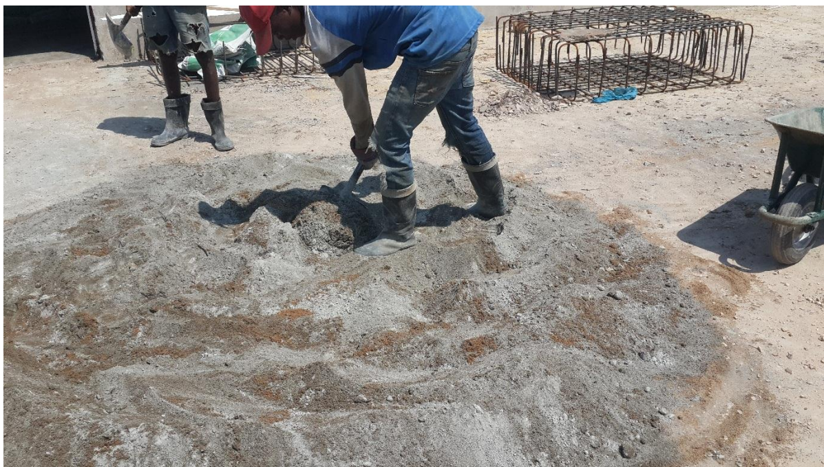
Fotografia 15: Mistura de areia e cimento em camada de 10 a 15cm (Fonte:Autor)
