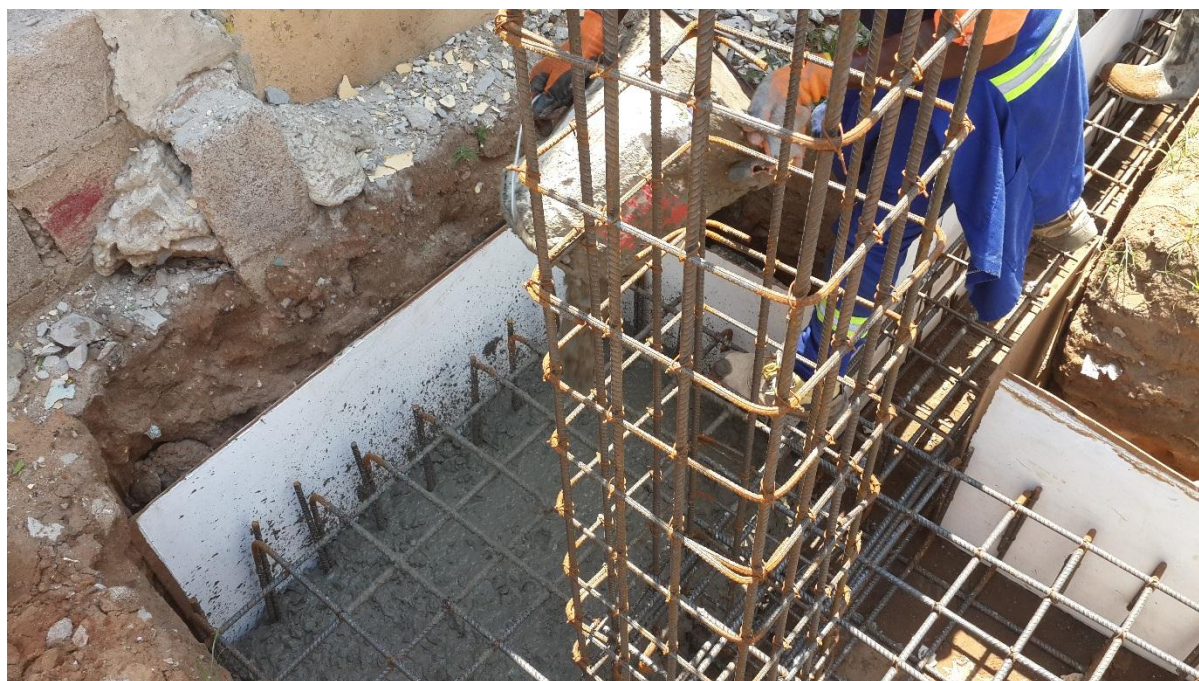
Fotografia 18: Betonagem ``Método de Fila Indiana`` (Fonte: Autor)
