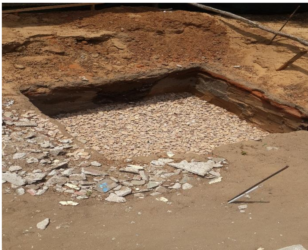
Fotografia 5: Aplicação do enrocamento (Fonte: Autor)
