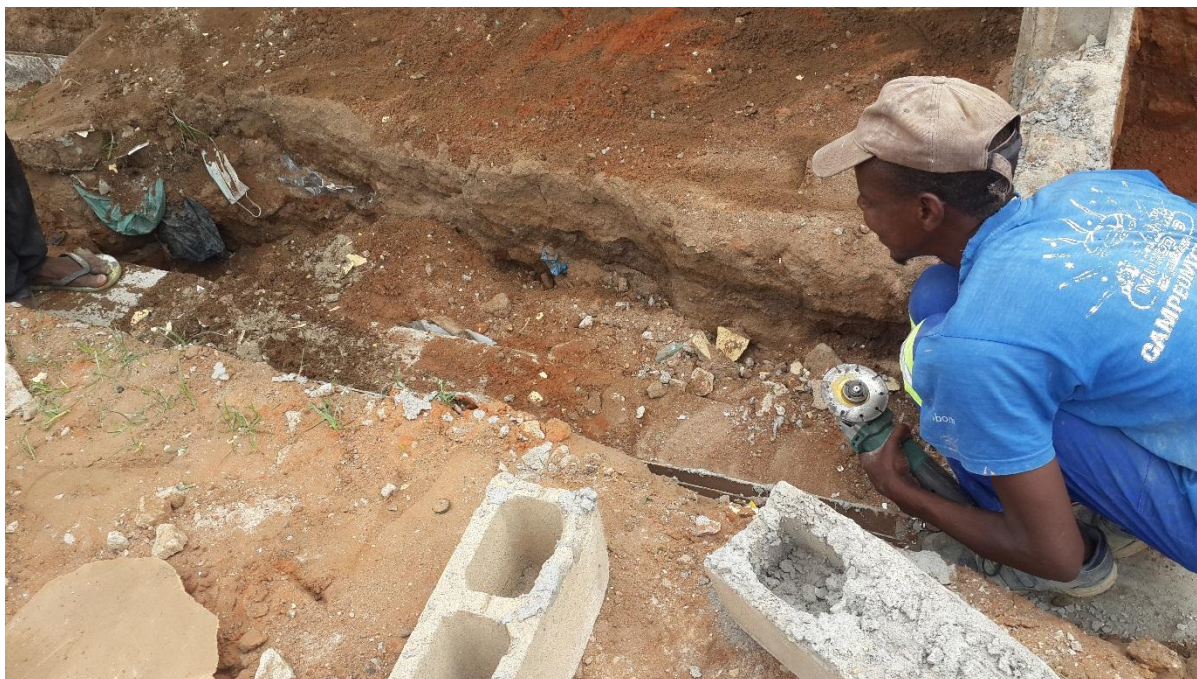
Fotografia 22: Remoção de alguma cofragem perdida para posterior aterro (Fonte: Autor)
