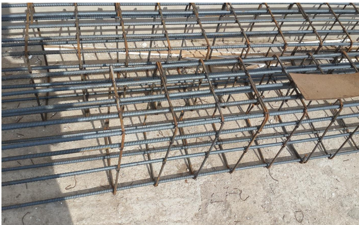
Fotografia 13: Armadura da viga de equilíbrio (Fonte: Autor)
