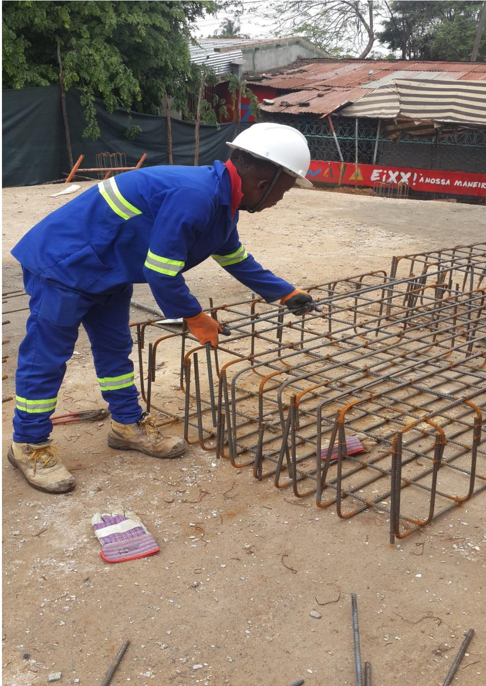
Fotografia 11: Armação da armadura das sapatas (Fonte: Autor)
