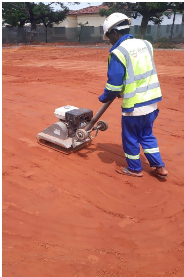
Fotografia 5: Compactação e nivelamento (Fonte: Autor)
