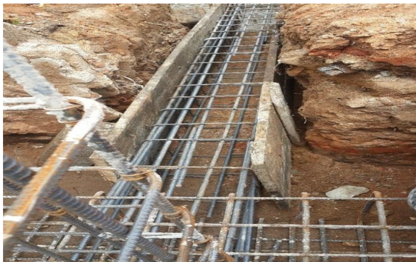
Fotografia 7: Cofragem de madeira aproveitável (Fonte: Autor)
