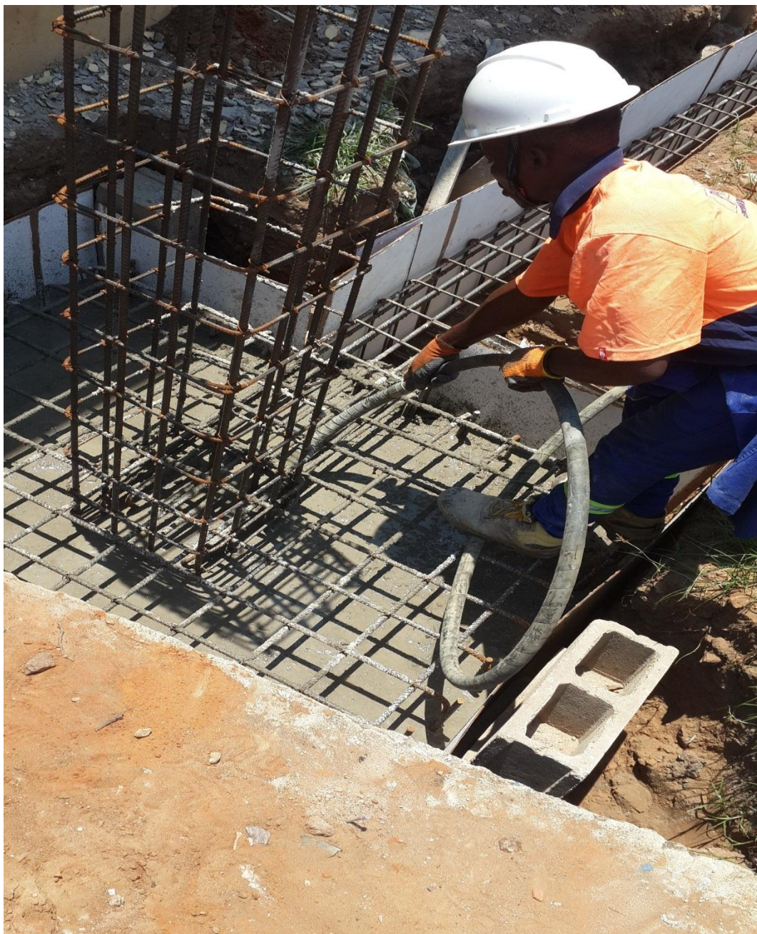
Fotografia 21: Processo de compactação por vibração (Fonte: Autor)
