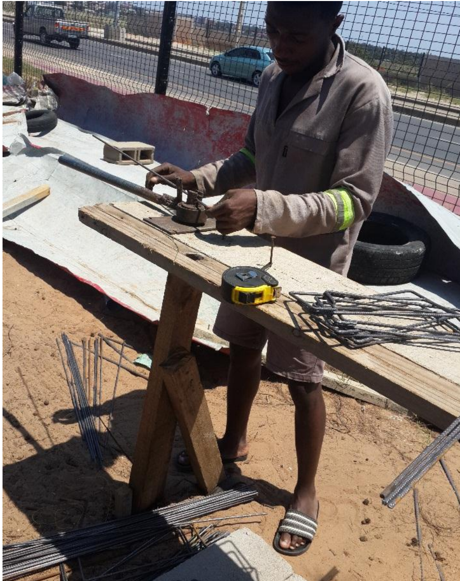
Fotografia 2: Preparação das cintas (estribos) (Fonte: Autor)
