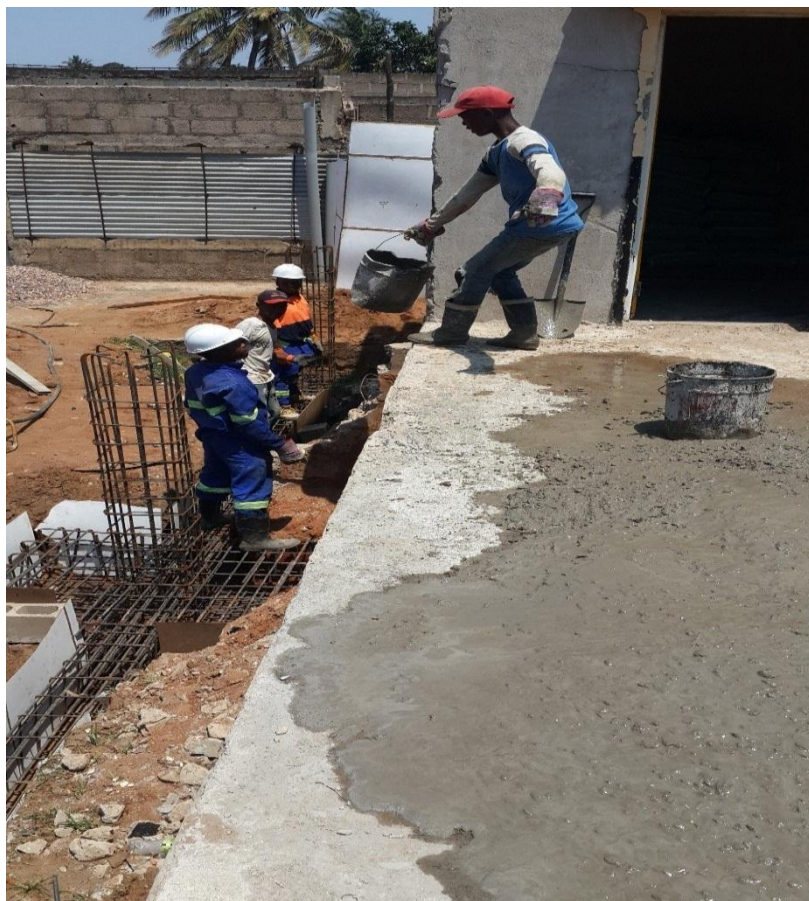
Fotografia 18: Betonagem ``Método de Fila Indiana`` (Fonte: Autor)
