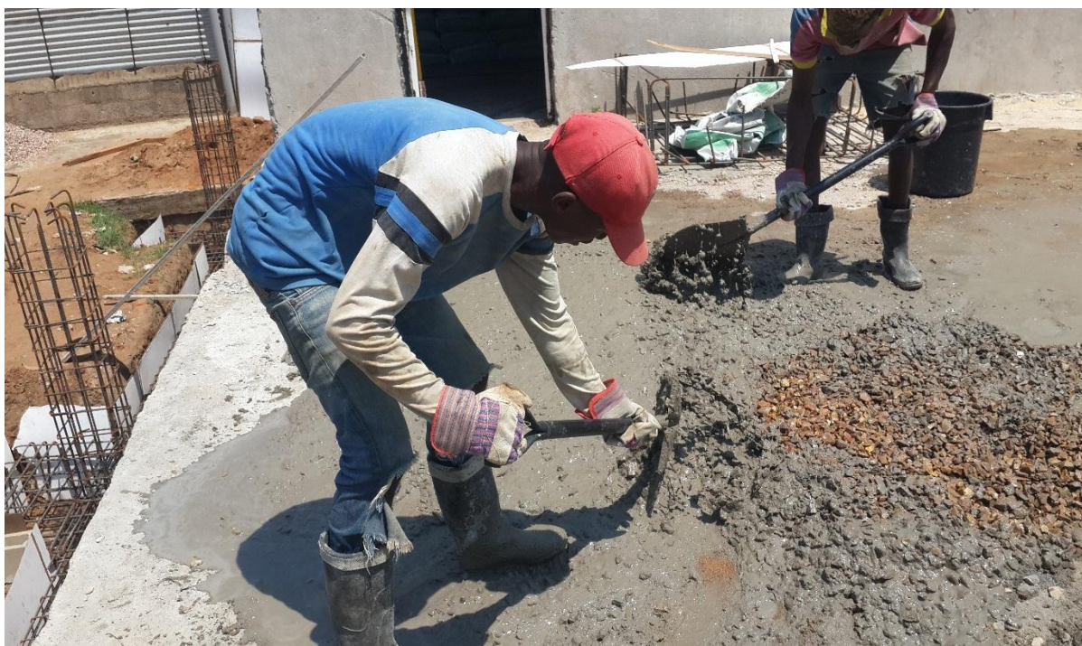
Fotografia 16: Mistura de todos elementos do betão (Cimento, Areia, Brita e água) (Fonte: Autor)
