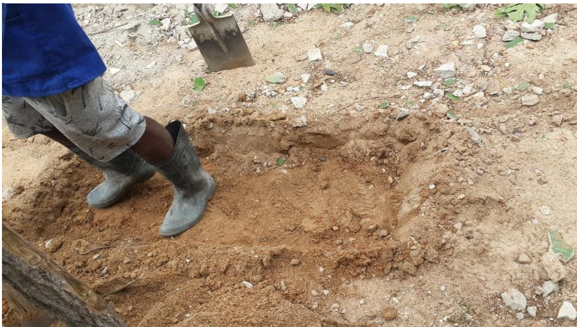
Fotografia 4: Abertura do cabouco (Fonte: Autor)
