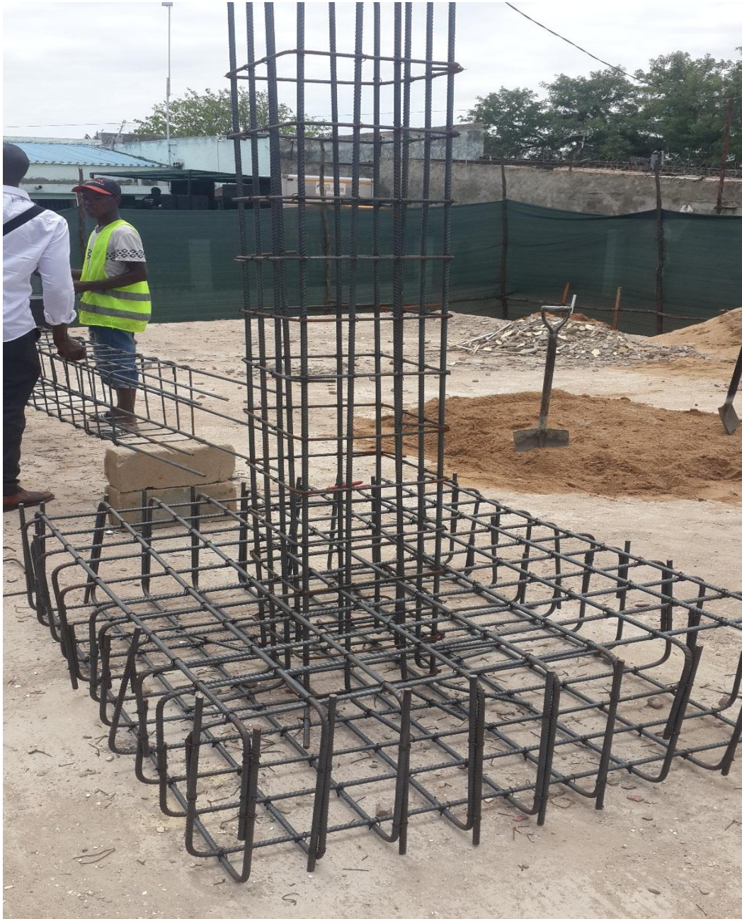
Fotografia 12: Armadura do pilar já embutida na armadura da sapata (Fonte: Autor)
