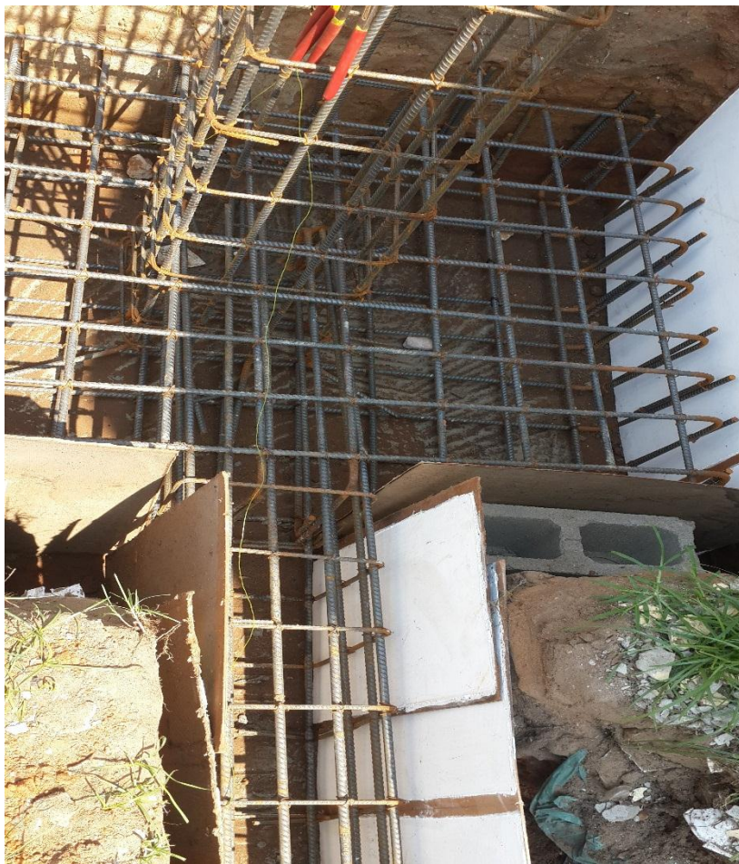
Fotografia 9.1: Cofragem perdida e Espaçadores na armadura da sapata (Fonte: Autor)
