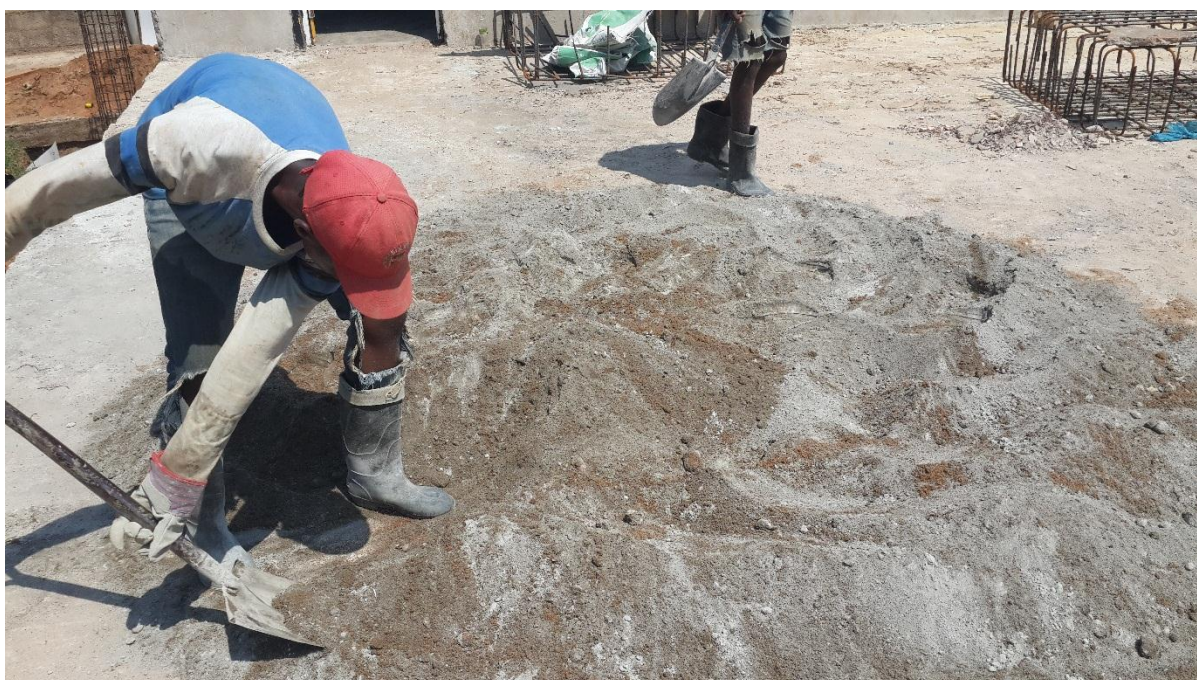
Fotografia 15: Mistura de areia e cimento em camada de 10 a 15cm (Fonte:Autor)
