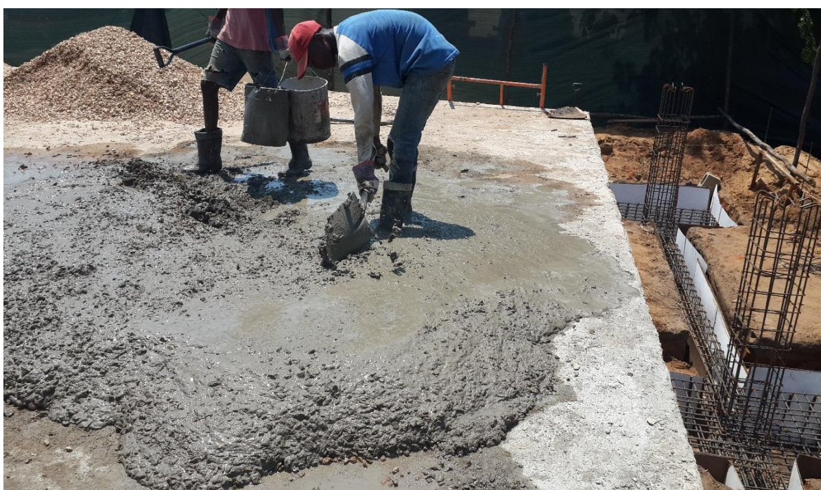
Fotografia 16: Mistura de todos elementos do betão (Cimento, Areia, Brita e água) (Fonte: Autor)
