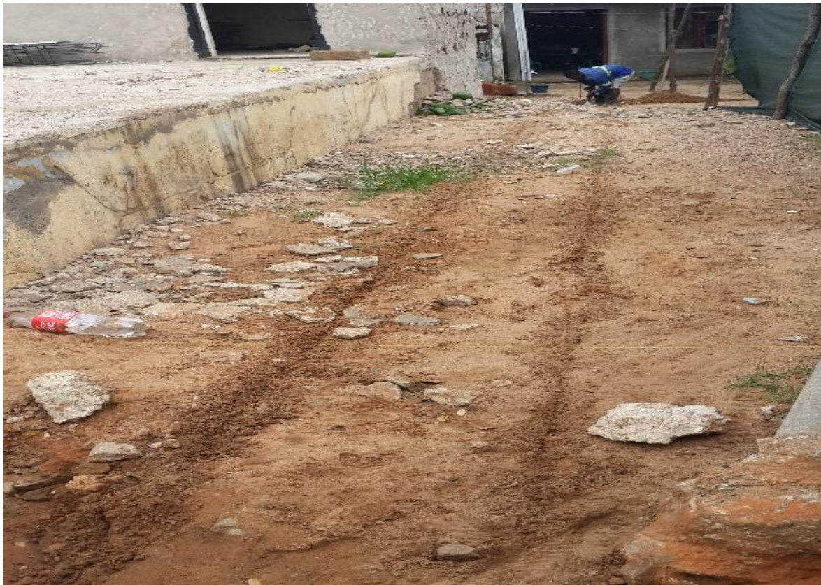
Fotografia 3: Marcação do Cabouco (Fonte: Autor)
