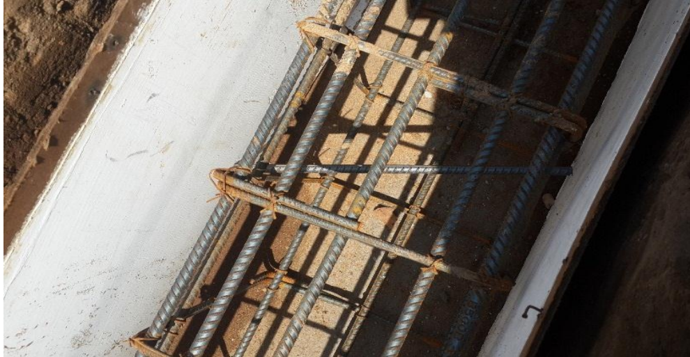
Fotografia 8: Cofragem perdida e Espaçadores em aço na armadura da viga de equilíbrio (Fonte: Autor)
