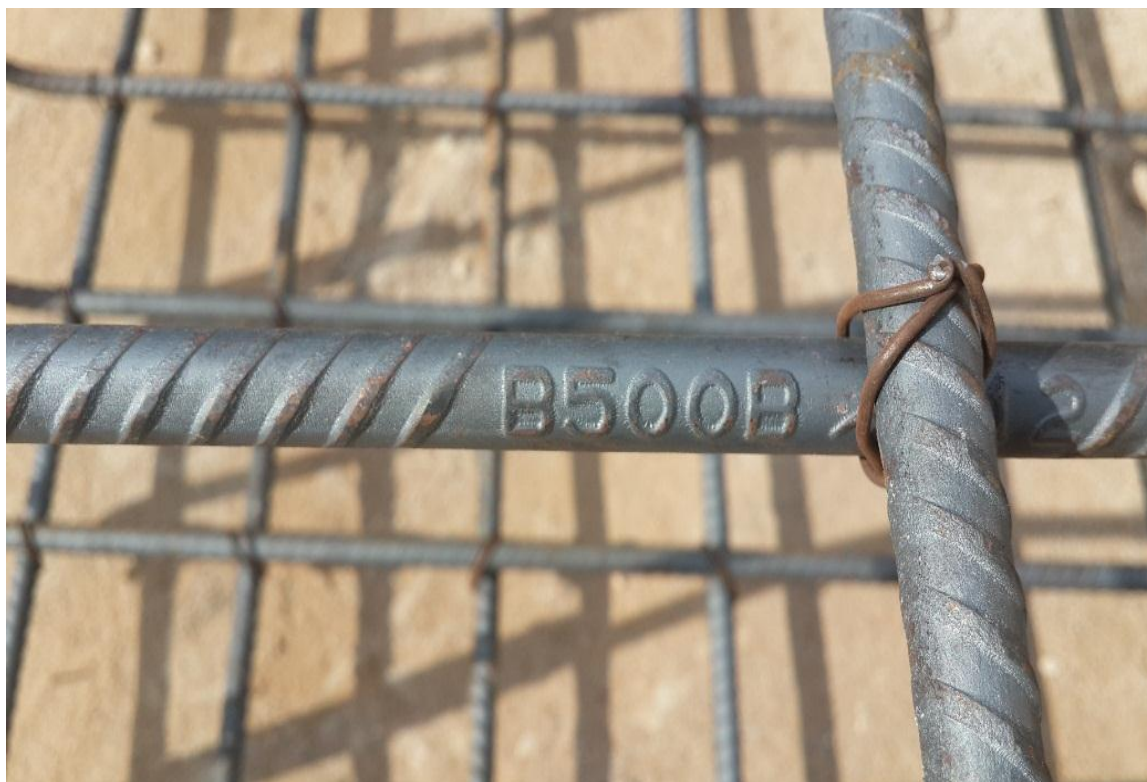
Fotografia 10: Amarração das armaduras (Fonte: Autor)
