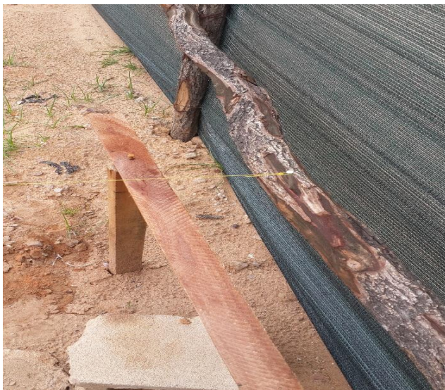
Fotografia 2: Cangalho em madeira ou estaca (Fonte: Autor)
