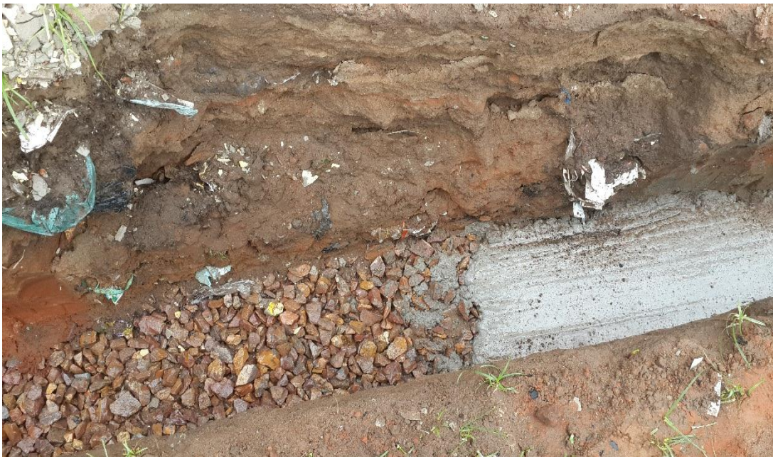
Fotografia 6: Aplicação do betão de limpeza sobre o enrocamento (Fonte: Autor)
