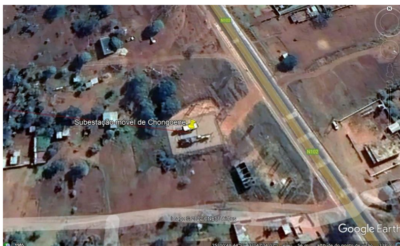
Figura 13 - Localização da Subestação Móvel de Chongoene, (Fonte: Autor).
