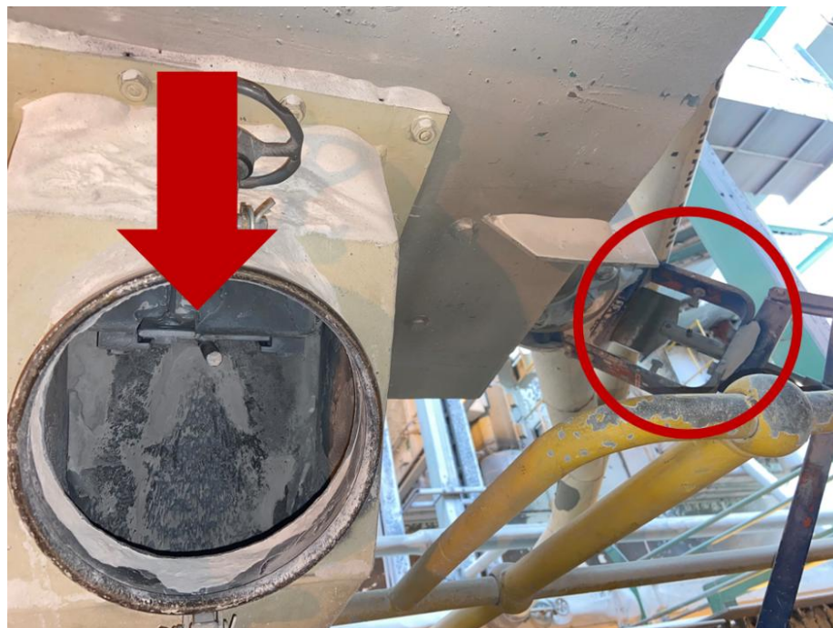
Figura 21: Filtro 8 sem material de recirculação e válvula de drenagem aberta.
