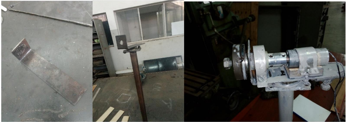
Figura 4.3 – Construção da nacela
