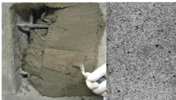
*Figura 21-Argamassa aplicada manualmente(Fonte:Sika)*
