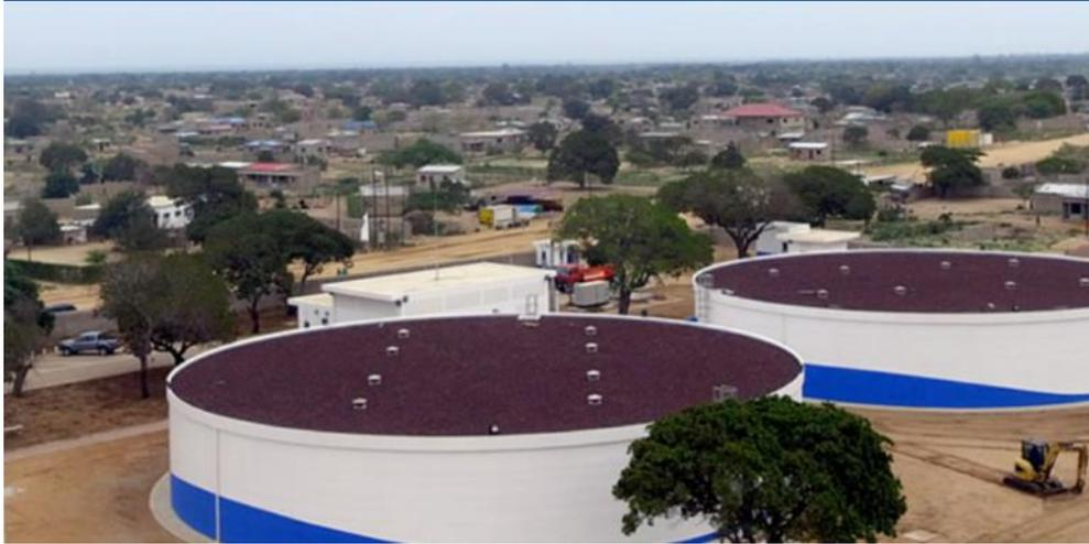
*Figura 7-Reservatório com duas células (fonte:Grupo Norvia)*
