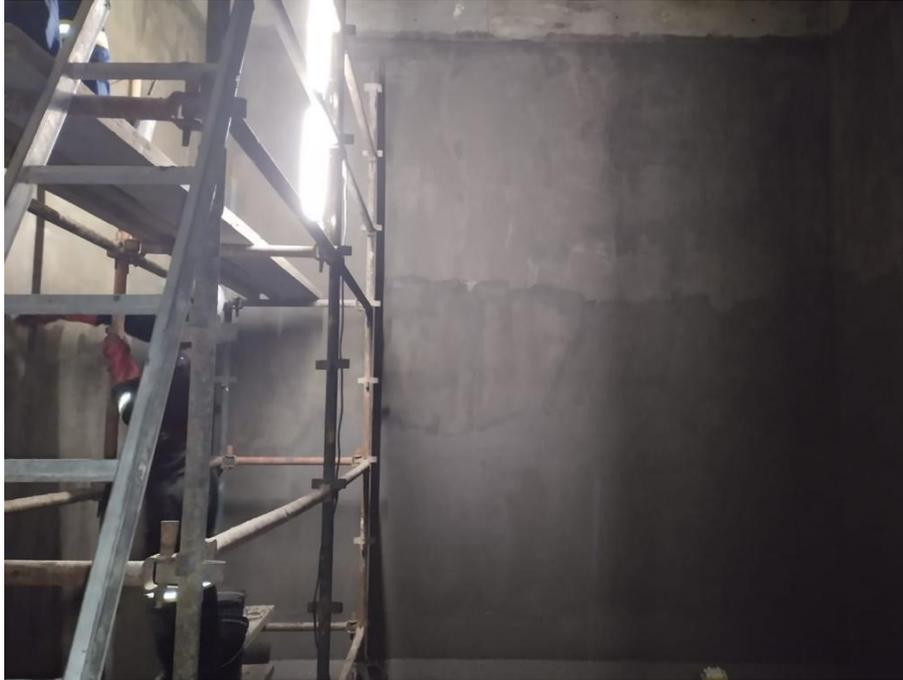
*Figura 8-Parede após aplicação da argamassa impermeabilizante*
