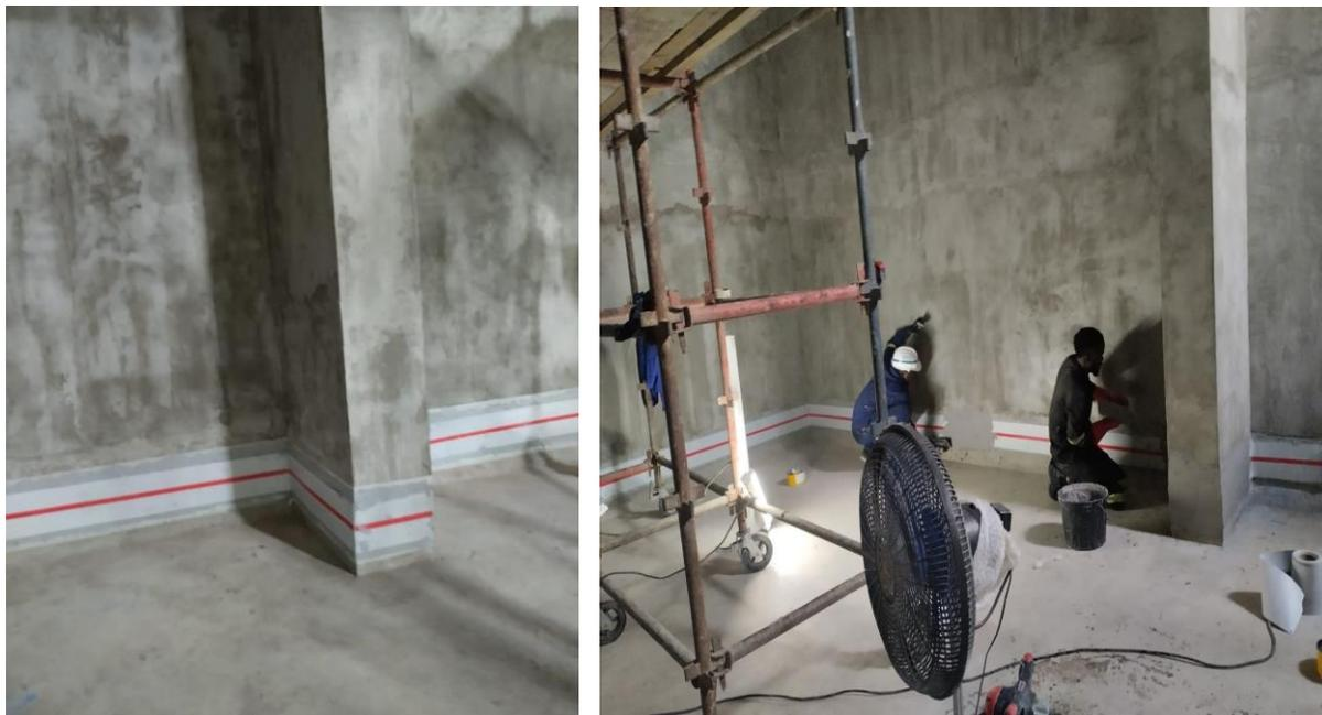
*Figura 5-Aplicação do adesivo estrutural a base de epoxi após selagem das juntas*
