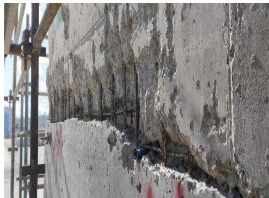
*Figura 17-Aberturas ao longo das paredes*
