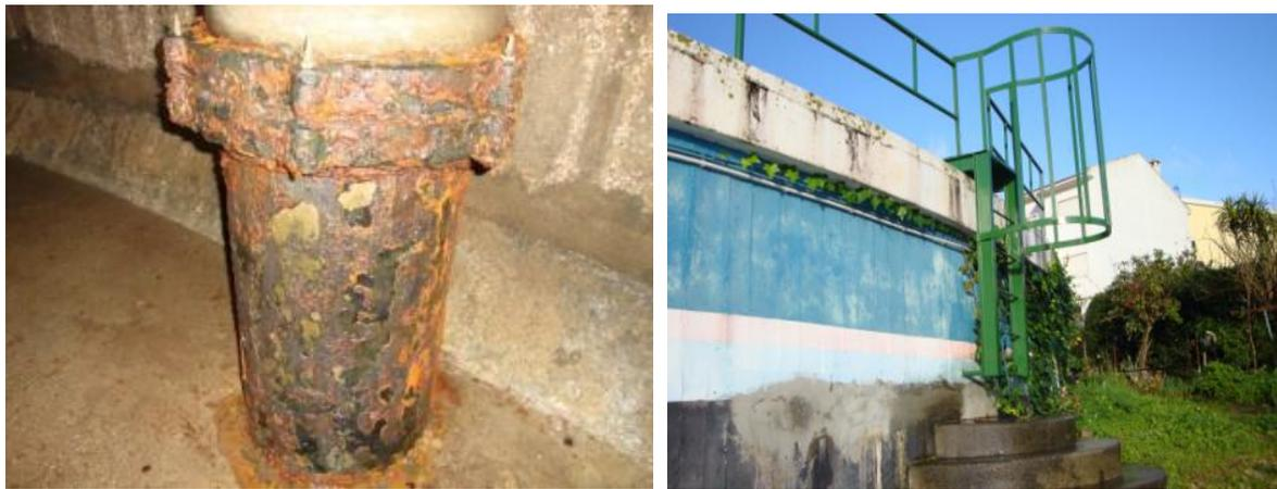
*Figura 12-Elemento metálico ferrosos, escada de acesso à cobertura e elemento de protecção na laje da cobertura (Pereira ,2010)*
