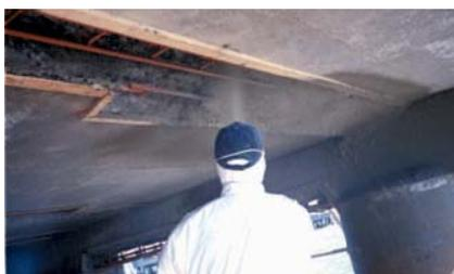
A melhor qualidade e facilidade de aplicação pode ser alcançada com argamassas de reparação Emaco: Emaco Nanocrete R4 / R3 aplicados por projecção.
