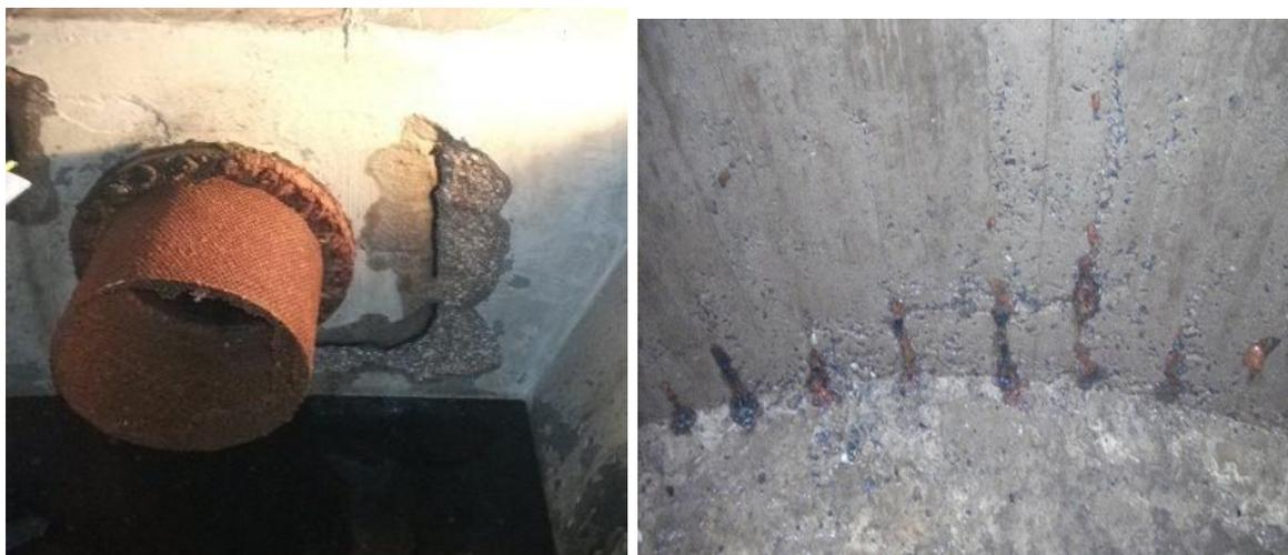
*Figura 8-Armadura a vista devido ao fenómeno de carbonatação, oxidação de armaduras devido a presença de cloretos (Guedes, 2014)*
