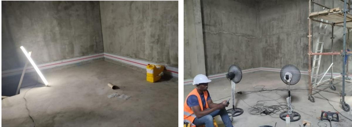
*Figura 4-Processo de secagem do sistema de selagem de junta*
