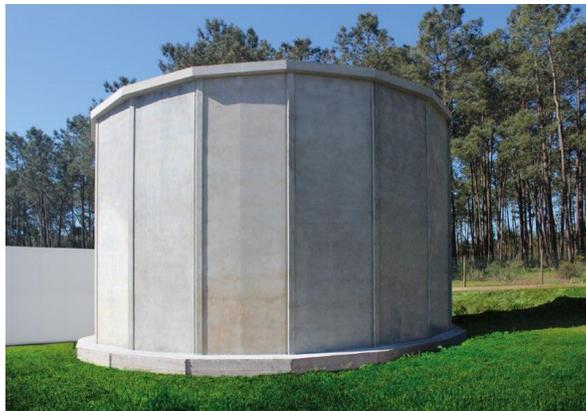
*Figura 6-Reservatório poligonal. (fonte: catálogo sirolis pré-fabricados em betão)*
