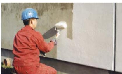
Humidade no betão pode ser controlada com revestimentos protectores Masterseal, acrílicos, EP ou PU, rígidos ou flexíveis.
