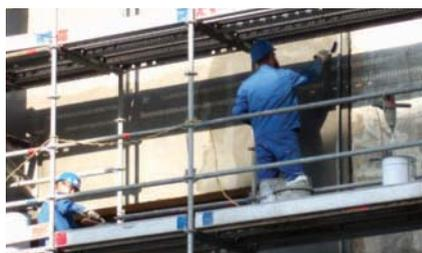
Argamassas de reparação Emaco: Emaco Nanocrete R4 / R3 / R2 / FC aplicadas manualmente.
