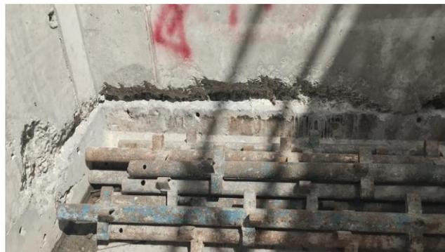
*Figura 19- Degradação do betão nas juntas*
