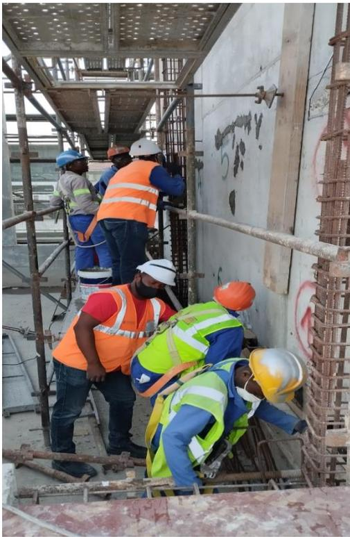
*Figura 2- Aplicação das argamassas de reparação*
