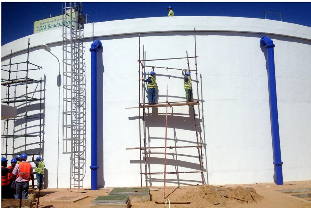
*Figura 1-Reservatório em betão armado para abastecimento e distribuição de água (Fonte:FIPAG)*
