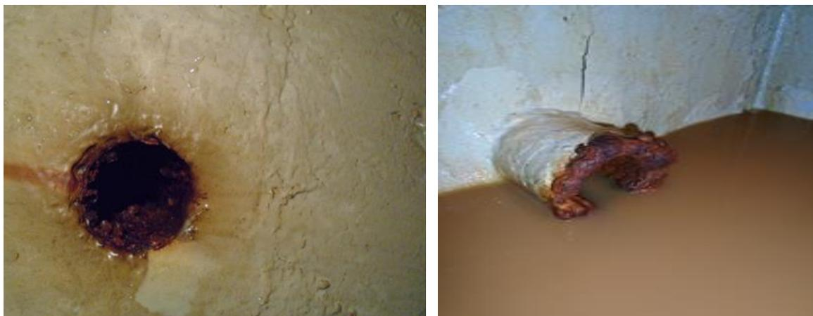
*Figura 13-Tubagem para água da rede de distribuição e tubagem para a descarga de fundo (Jardim, 2016)*
