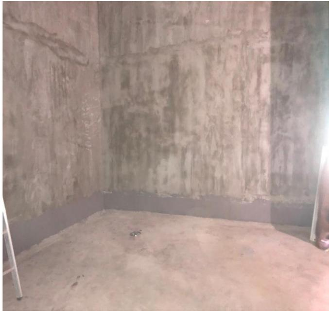
*Figura 6-Juntas após selagem completa*
