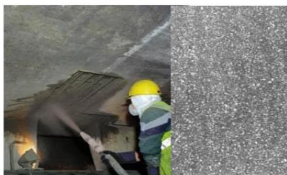
*Figura 22-Argamassa aplicada por projecção(Fonte:Sika)*
