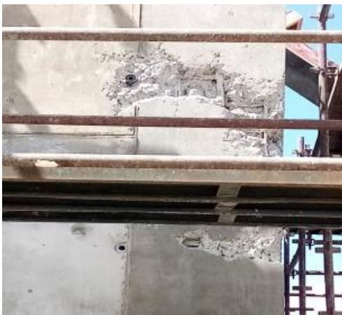
*Figura 18-Paredes degradadas com armadura a vista*
