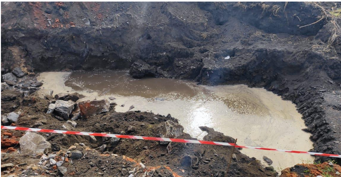
Figura 6 Colocação da camada de rachão
