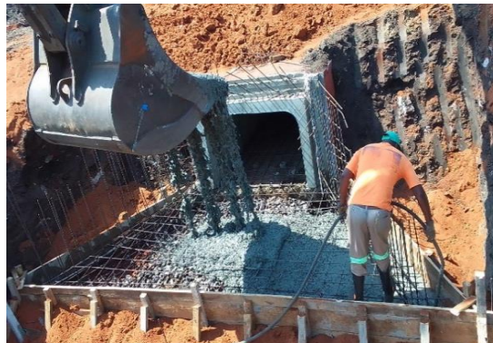
Figura 29 Betonagem da soleira
