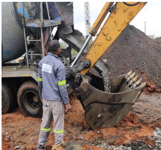
Figura 14 Deposição de betão na caçamba da escavadeira
