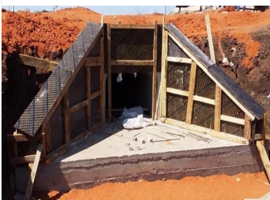
Figura 27 Cofragem dos muros
