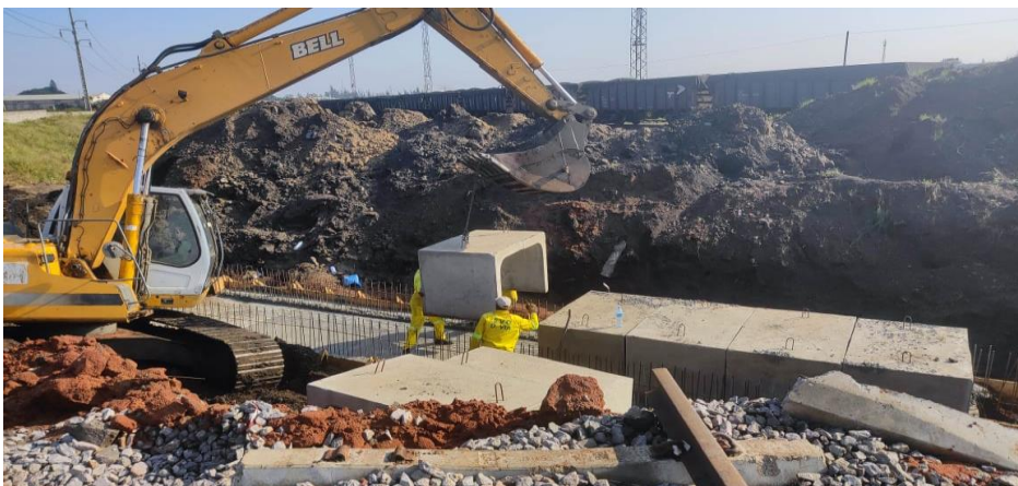
Figura 9 Assentamento das BC's
