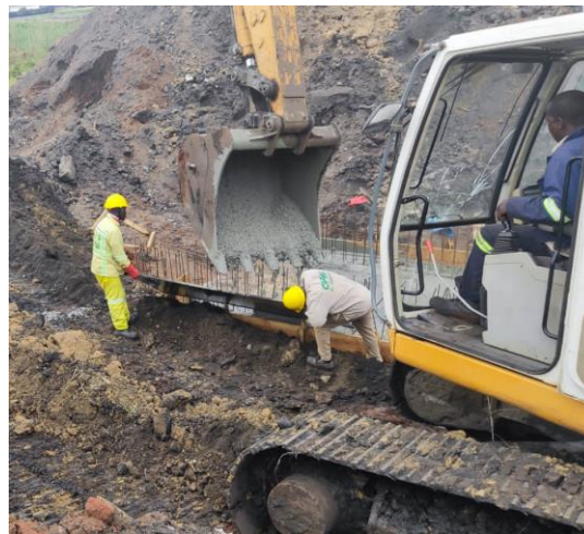
Figura 15 Deposição de betão na fundação
