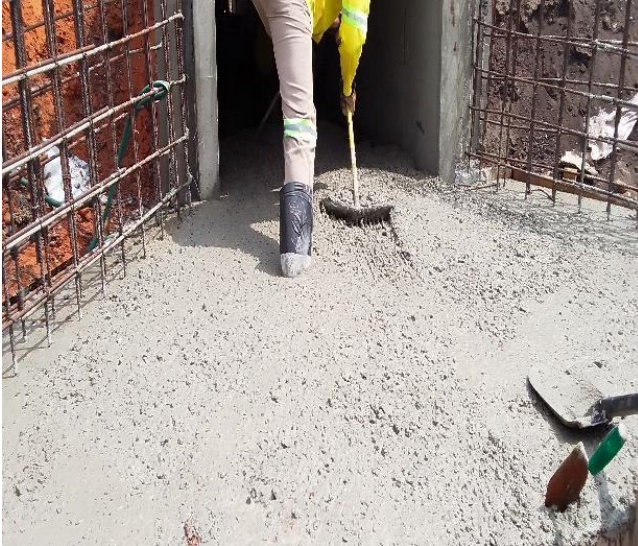
Figura 25 Betonagem do leito das BC's
