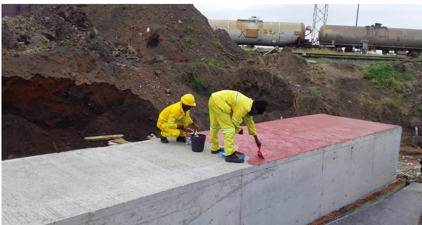
Figura 37 Impermeabilização da estrutura de encamisamento
