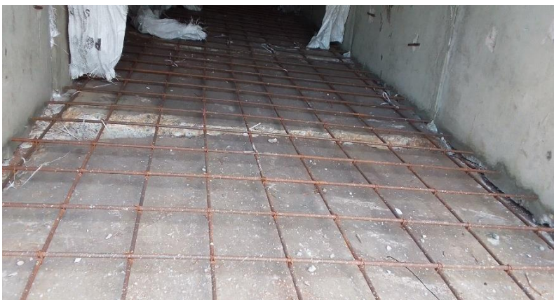
Figura 22 Malha dentro das BC's
