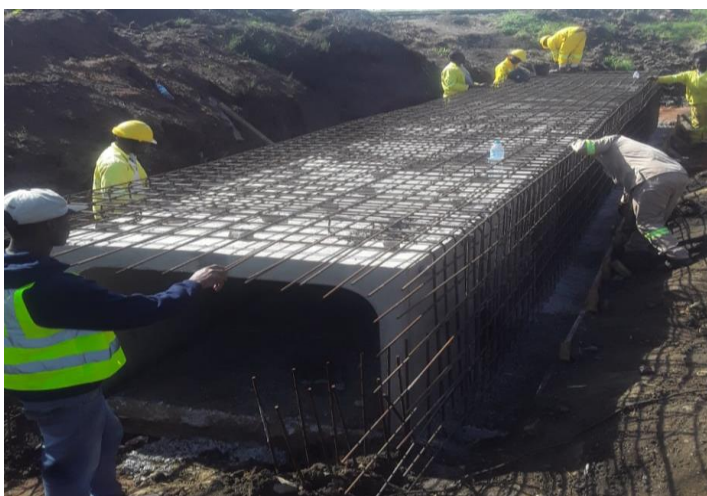
Figura 17 Colocação da malha para estrutura de encamisamento
