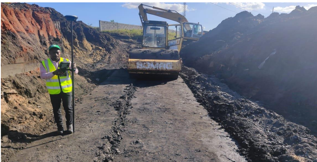
Figura 7 Compactação da camada de rachão
