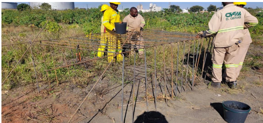
Figura 16 Preparação da malha da estrutura de encamisamento
