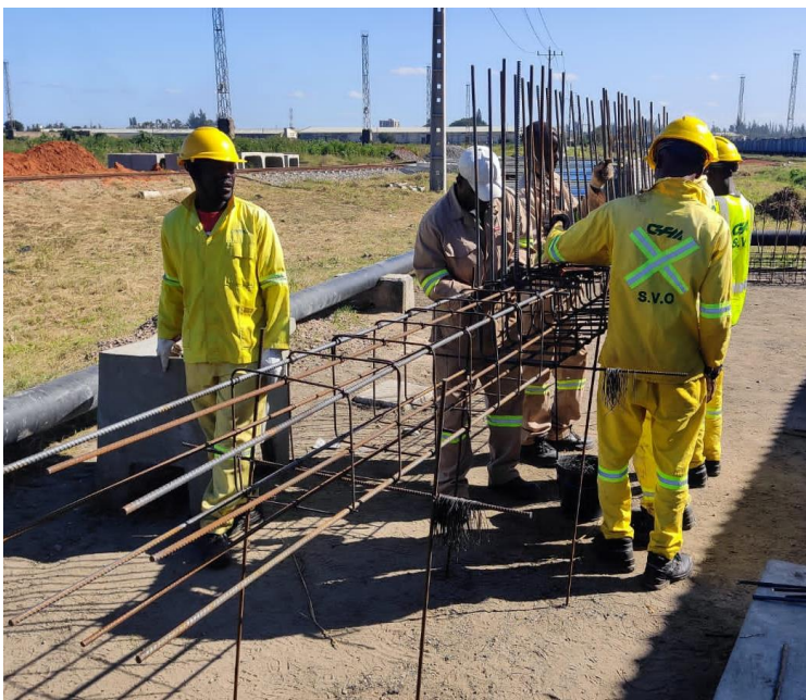
Figura 11 Preparação da armadura da fundação
