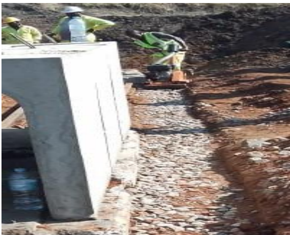
Figura 10 Compactação da brita para fundações de estrutura de encamisamento
