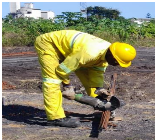
Figura 36 Corte de varões
