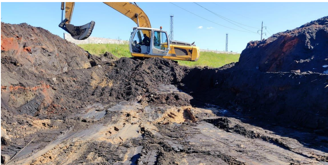
Figura 4 Escavação da área de para implantação do aqueduto
