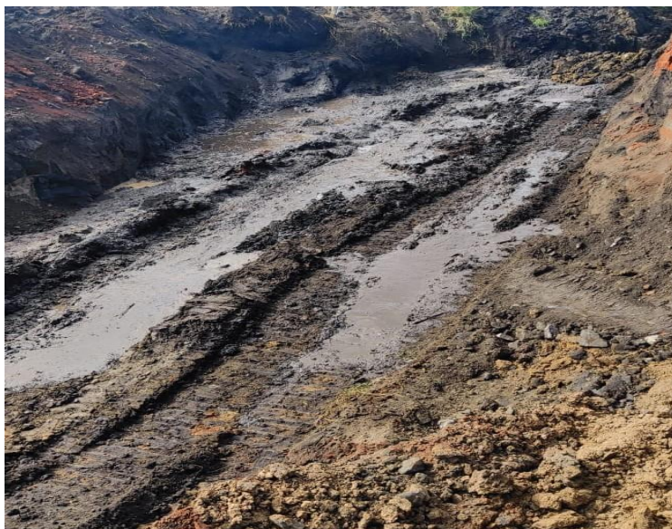
Figura 5 Solos moles saturados com o nível freático elevado
