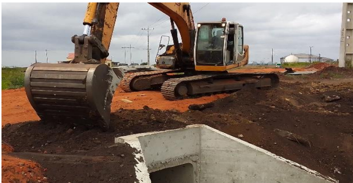
Figura 30 Reaterro por trás dos muros
