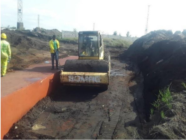
Figura 23 Reaterro e compactação de solos
