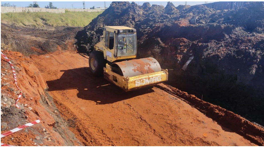
Figura 8 Compactação da camada de solos vermelhos
