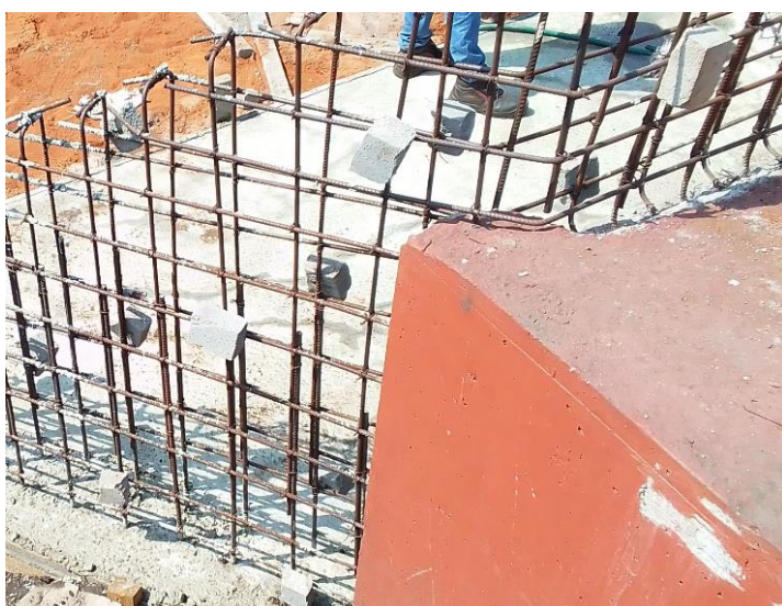
Figura 32 Espaçadores de argamassa
