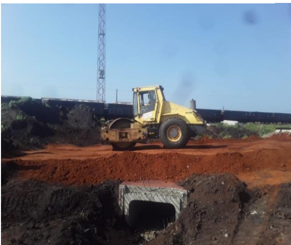
Figura 24 Aterro e compactação de solos vermelhos
