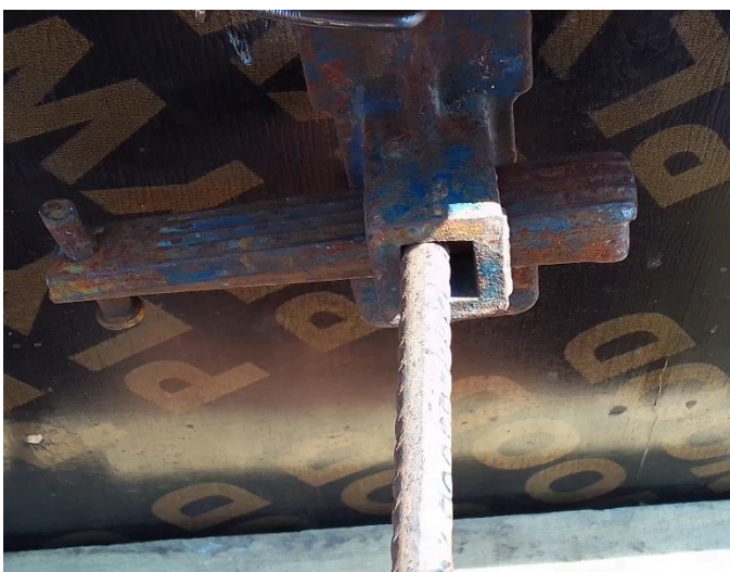
Figura 19 Ancoragem por castanhetas
