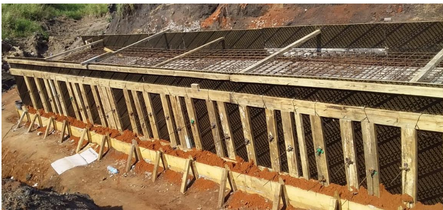
Figura 18 Cofragem dos muros e laje da estrutura de encamisamento
