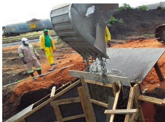
Figura 26 Betonagem dos muros
