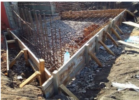
Figura 28 Cofragem e armação das soleiras
