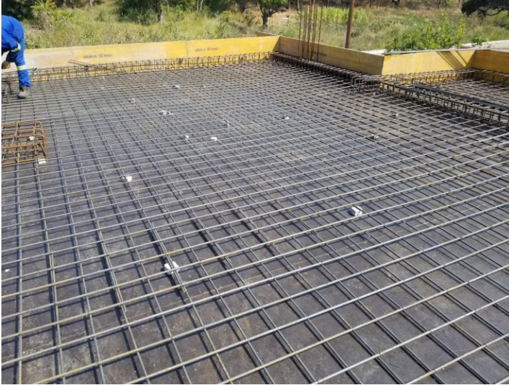
Figura 20- Montagem das armaduras da laje
