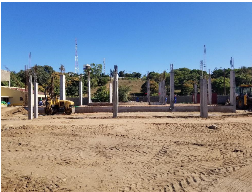
Figura 17- Pilares após a sua betonagem e descofragem
