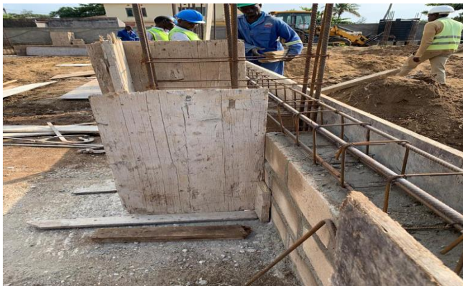
Figura 13 – Montagem das armaduras e cofragem dos lintéis de fundação.
