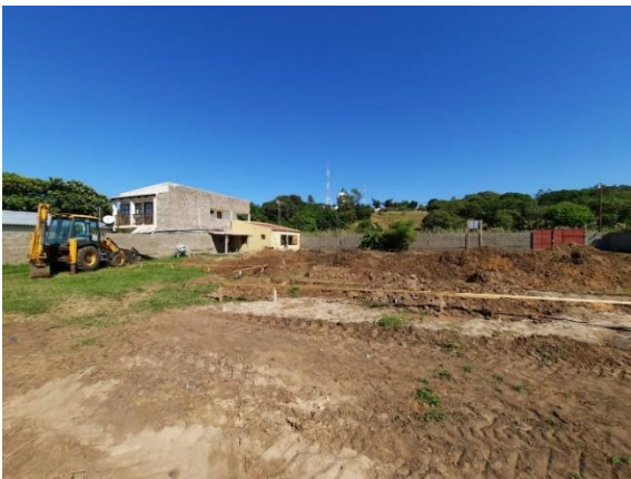
Figura 6- Decapagem de terra vegetal e escavação geral
