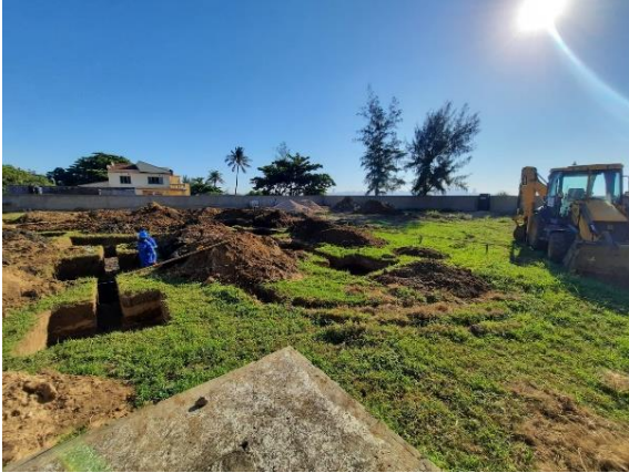
Figura 5- Abertura de caboucos para execução dos elementos de fundação
