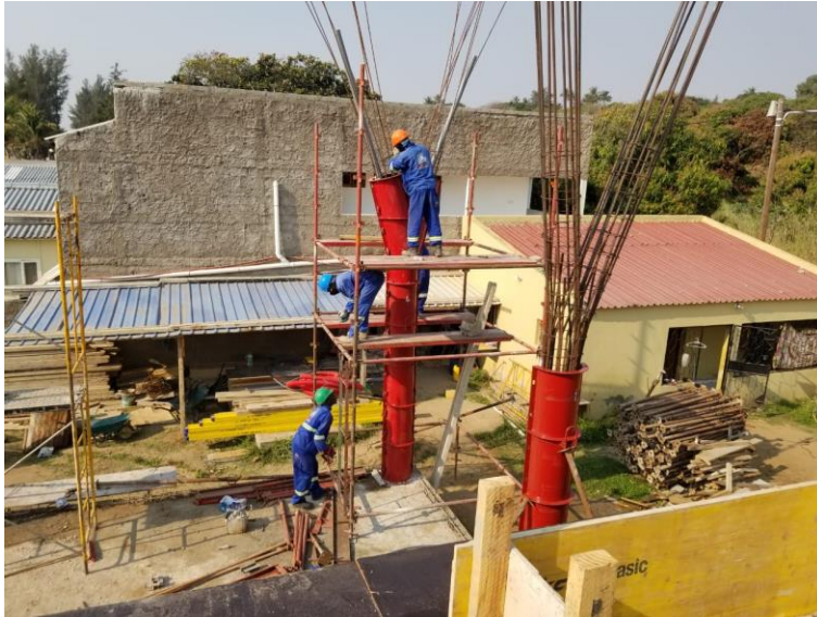
Figura 16- Cofragem dos pilares circulares
