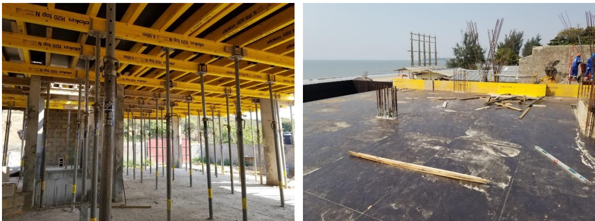
Figura 19- Cofragem da laje vista de baixo, à esquerda, e de cima, à direita
