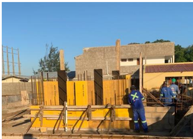
Figura 14- Cofragem da caixa de elevador
