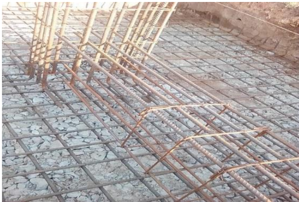
Figura 7- Montagem das armaduras das sapatas
