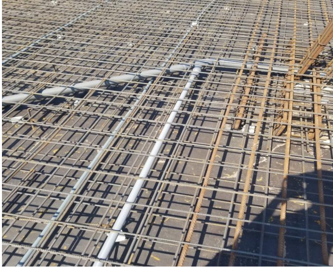
Figura 22- Instalação de tubagens de drenagem de águas residuais
