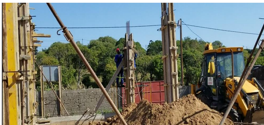
Figura 15 - Cofragem dos pilares rectangulares
