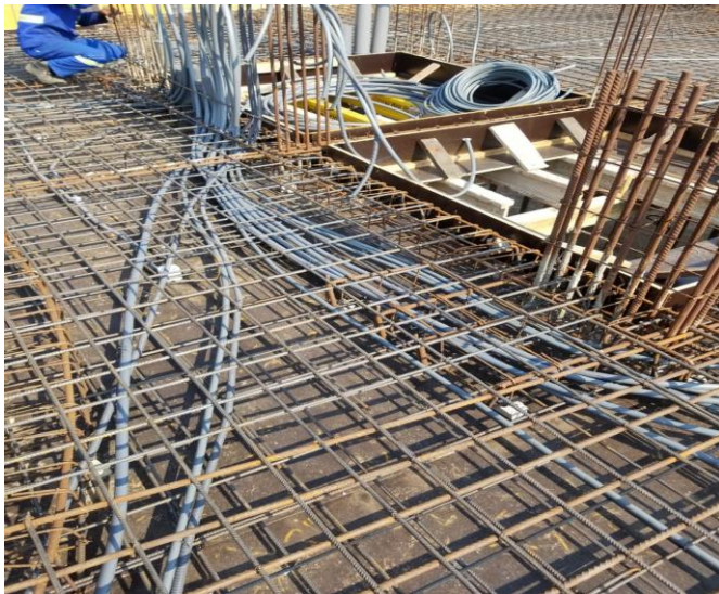
Figura 23- Instalação das tubagens de electricidade
