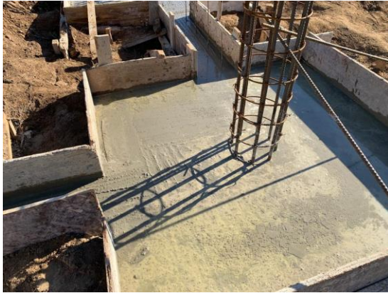
Figura 9 - Cofragem dos elementos de fundação
