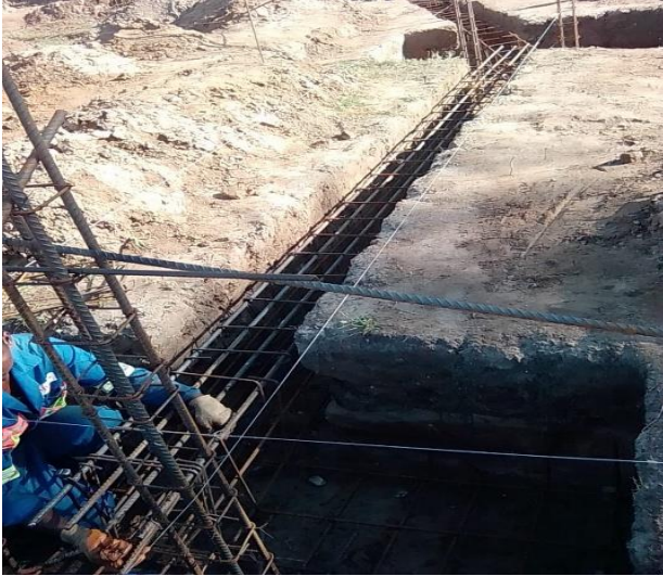
Figura 8- Montagem das armaduras das vigas de fundação
