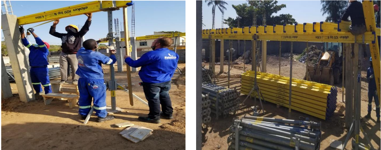
Figura 18- À esquerda, colocação das longarinas apoiadas nos topos dos prumos e respectivo nivelamento e, à direita, colocação das carlingas sobre as longarinas
