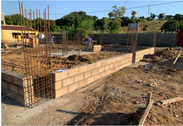
Figura 12- Alinhamento da alvenaria de fundação
