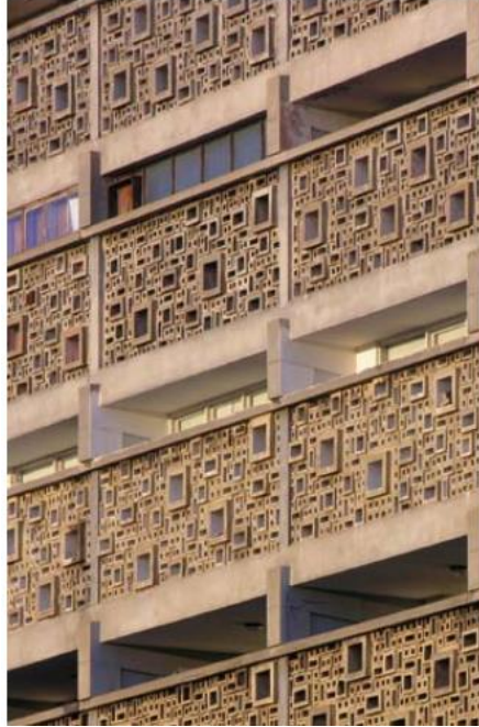
Figura 13: Utilização de “Brise Soleil” para sombreamento de fachada num edifício projectado pelo Arq. Pancho Guedes, em Maputo. Fonte: (FORJAZ, et al., 2009).
