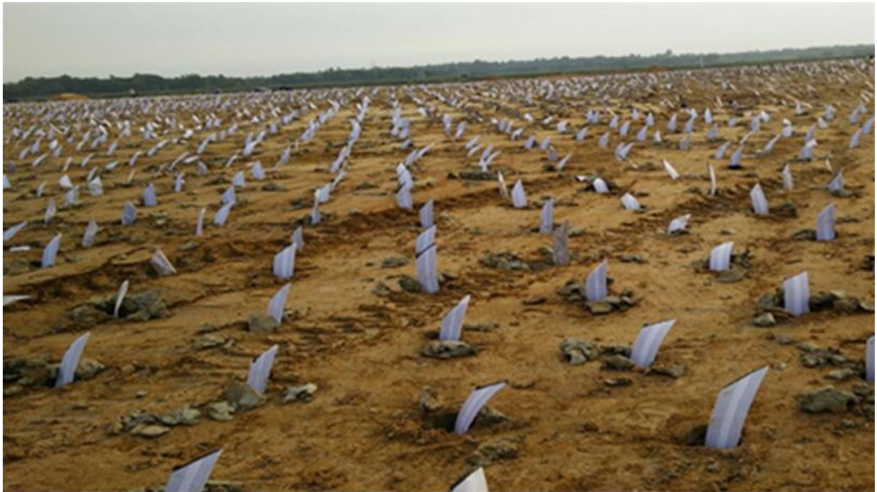
Figura A1. 3 - término da instalação de geodrenos.
