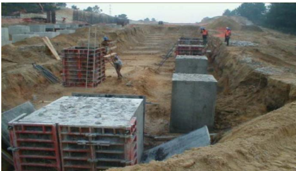
Figura 11 Fundações por poços.
