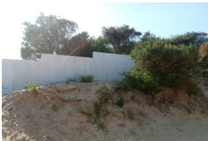
Figura 4: Obra de construção de um estabelecimento turístico.
