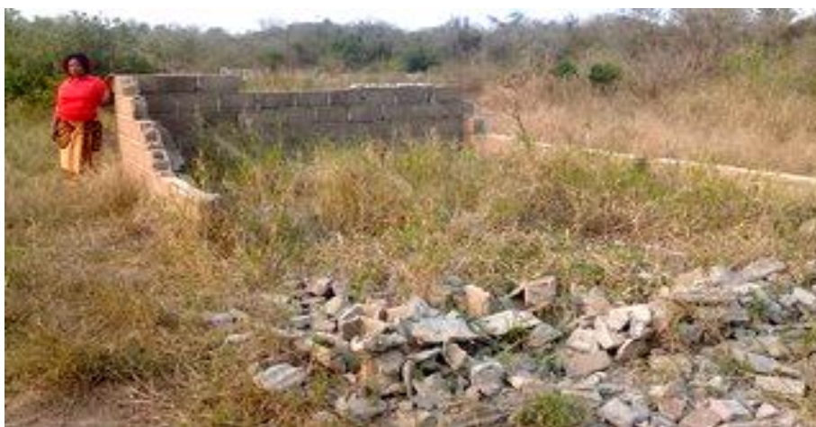
Figura 4: Casa destruída na área de abrangência da CIF-MOZ.
