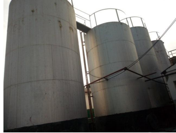
Figura 3: Tanques de armazenamento de óleo.
