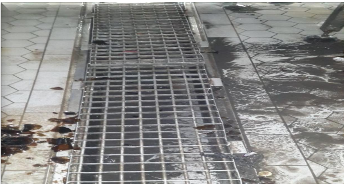
Fig.2. descaracterização do ambiente do trabalho
