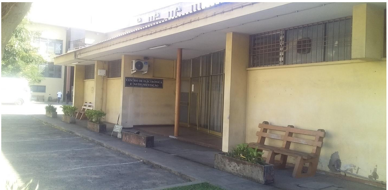
Figura 87: Centro de eletrônica e instrumentação. Fonte: (Autor, 2023)
