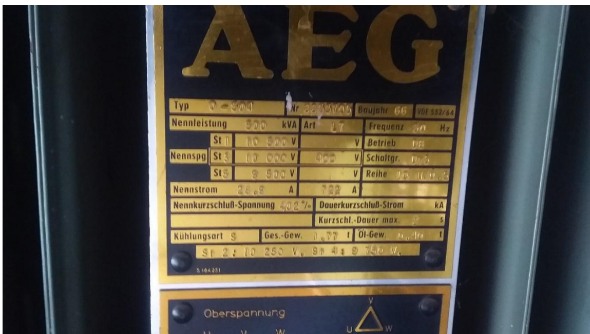
Figura 88: Chapa característica do transformador do PT do DEMA. Fonte: (Autor, 2023)
