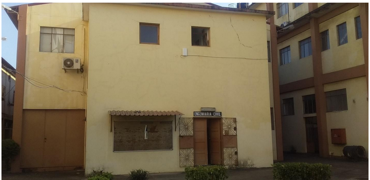
Figura 79: Departamento de Engenharia Civil. Fonte: (Autor, 2023)
