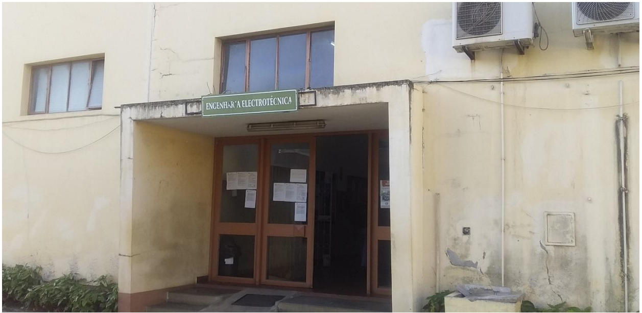
Figura 80: Departamento de Engenharia Electrotécnica. Fonte: (Autor, 2023)
