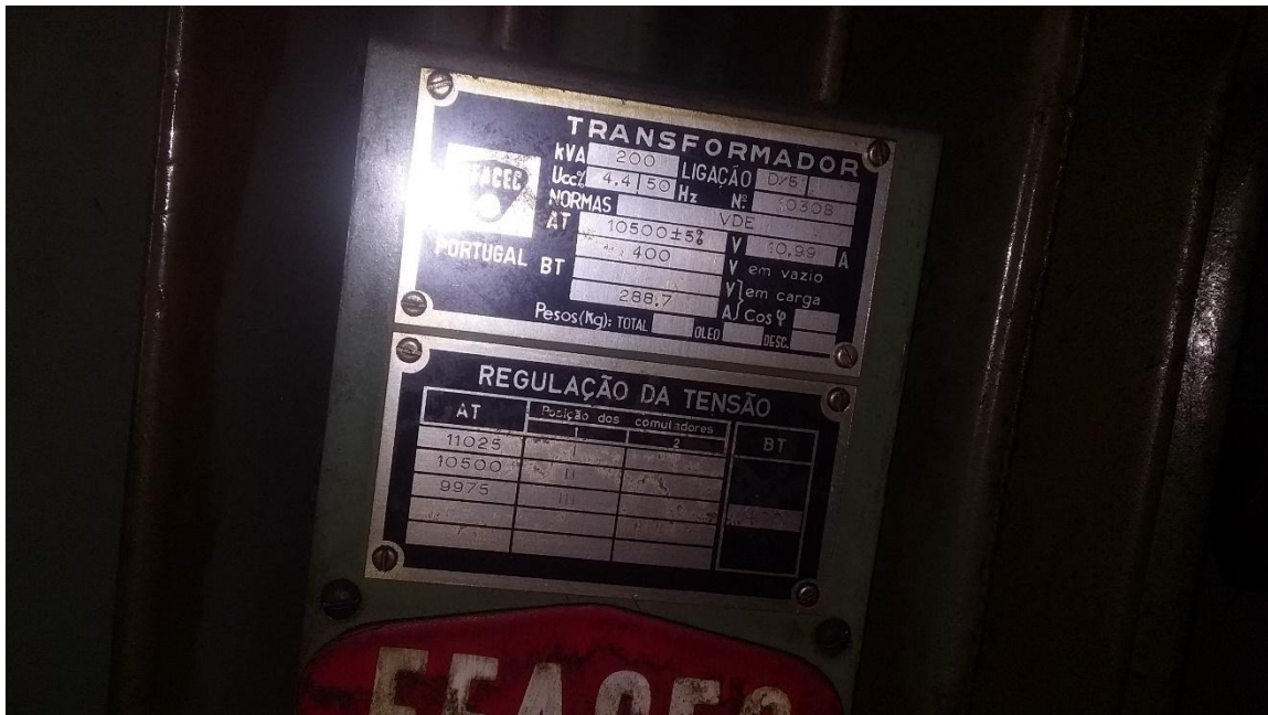
Figura 88: Chapa característica do transformador do PT do DEMA. Fonte: (Autor, 2023)
