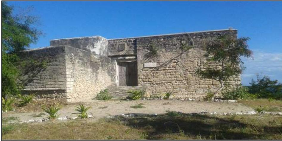
**Figura 4:** Vista frontal do Fortim São José na Ilha de Ibo, há sinais eminentes da corrosão das paredes (Jopela, 2014).
