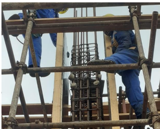
Figura 19. colocação dos espaçadores
