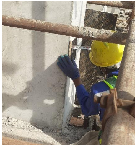
Figura 23. Medições para verificação do alinhamento do pilar
