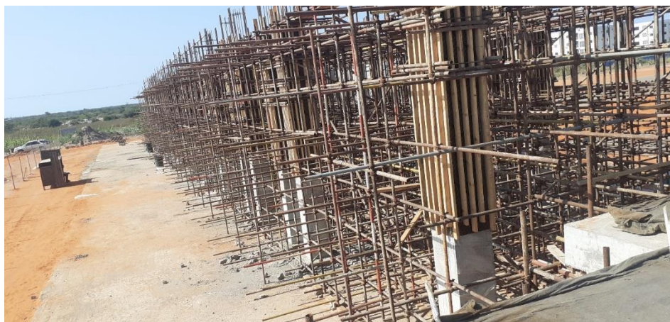
Figura 21. Disposição geral das escoramentos e cofragens
