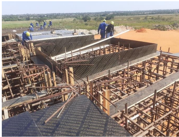
Figura 27. Montagem das cofragens para vigas e lajes.
