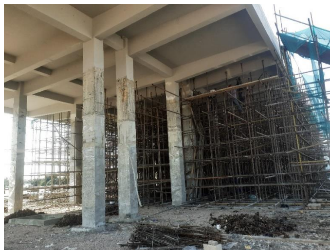
Figura 30. resultado final após a betonagem e cura da laje e vigas
