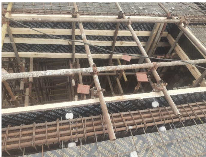
Figura 28. Disposição da cofragem da viga.
