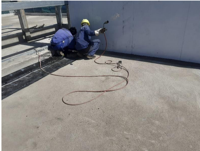
Figura 31. Aplicação da manta asfáltica
