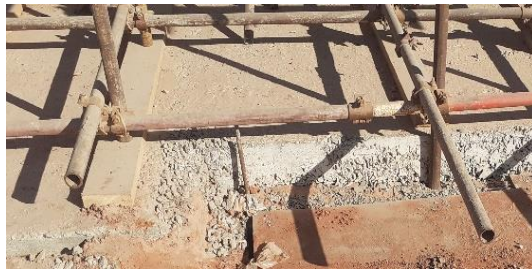
Figura 17. Pavimento provisório servindo de base de apoio do sistema de escoramentos do edifício principal.
