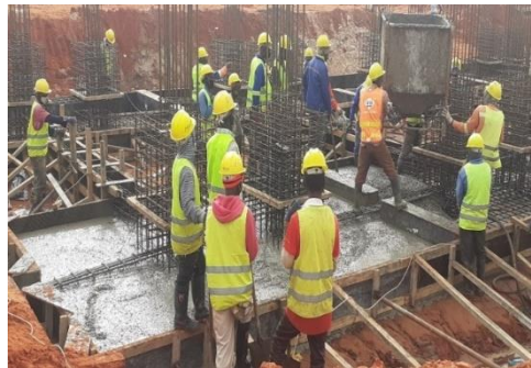
Figura 15. Transporte e colocação do betão nas sapatas
