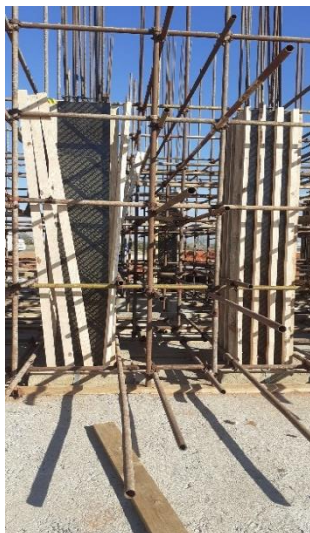
Figura 18. Preparação da montagem das cofragens.
