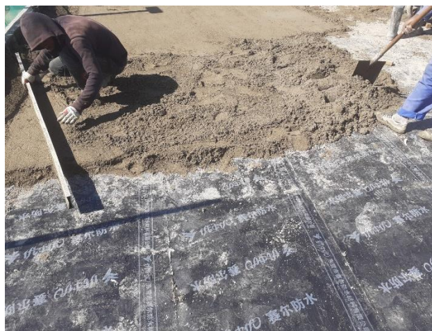
Figura 32. Aplicação de betonilha na laje
