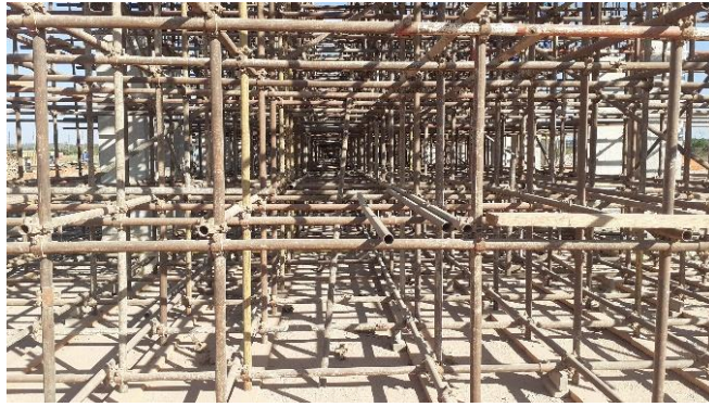
Figura 1. Escoramento vertical metálico normalizado apoiado no solo (Fonte: Autor)
