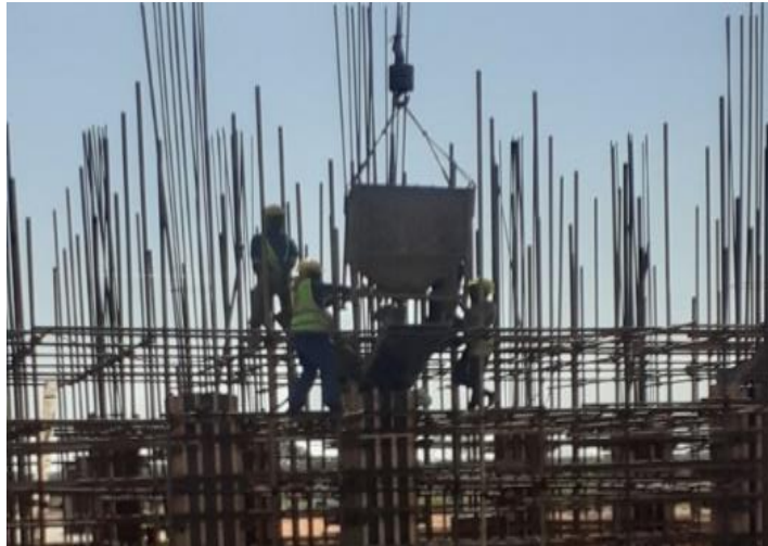
Figura 24. Betonagem dos pilares
