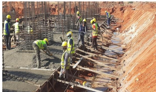
Figura 16. Nivelamento das superfícies das sapatas.
