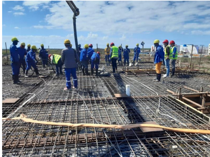
Figura 29. Betonagem da laje de cobertura e das vigas.
