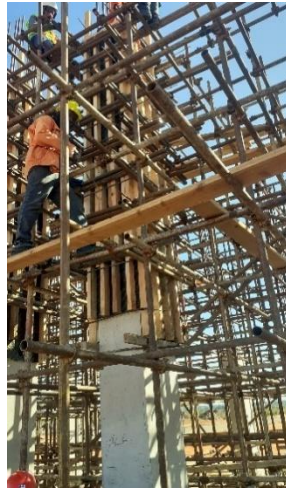
Figura 22. Verificação da verticalidade do pilar
