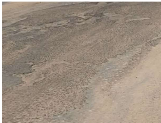
Figura 4. Remendo
