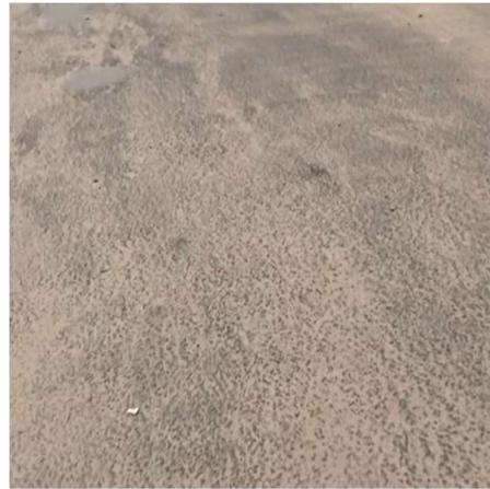
Figura 2. Desgaste
