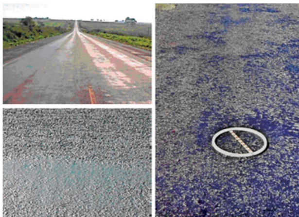
Figura 15. Ocorrências de Exsudação (Fontes: Norma DNIT 005/2003 - TER 2003 e Bernucci et al. , 2007)
