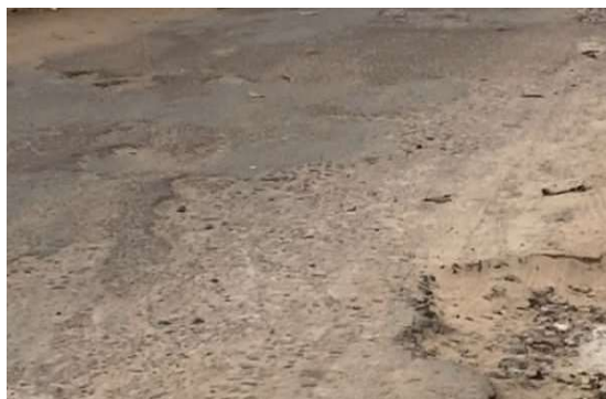
Figura 5. Remendo
