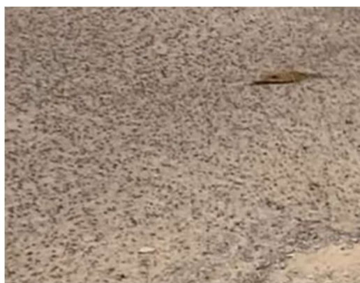
Figura 2. Desgaste
