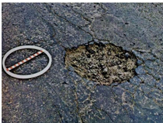
Figura 12. Buraco ou Panela (Fonte: Norma DNIT 005/2003 - TER 2003)
