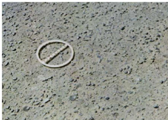
Figura 17. Desgaste (Fonte: Norma DNIT 005/2003 – TER 2003)
