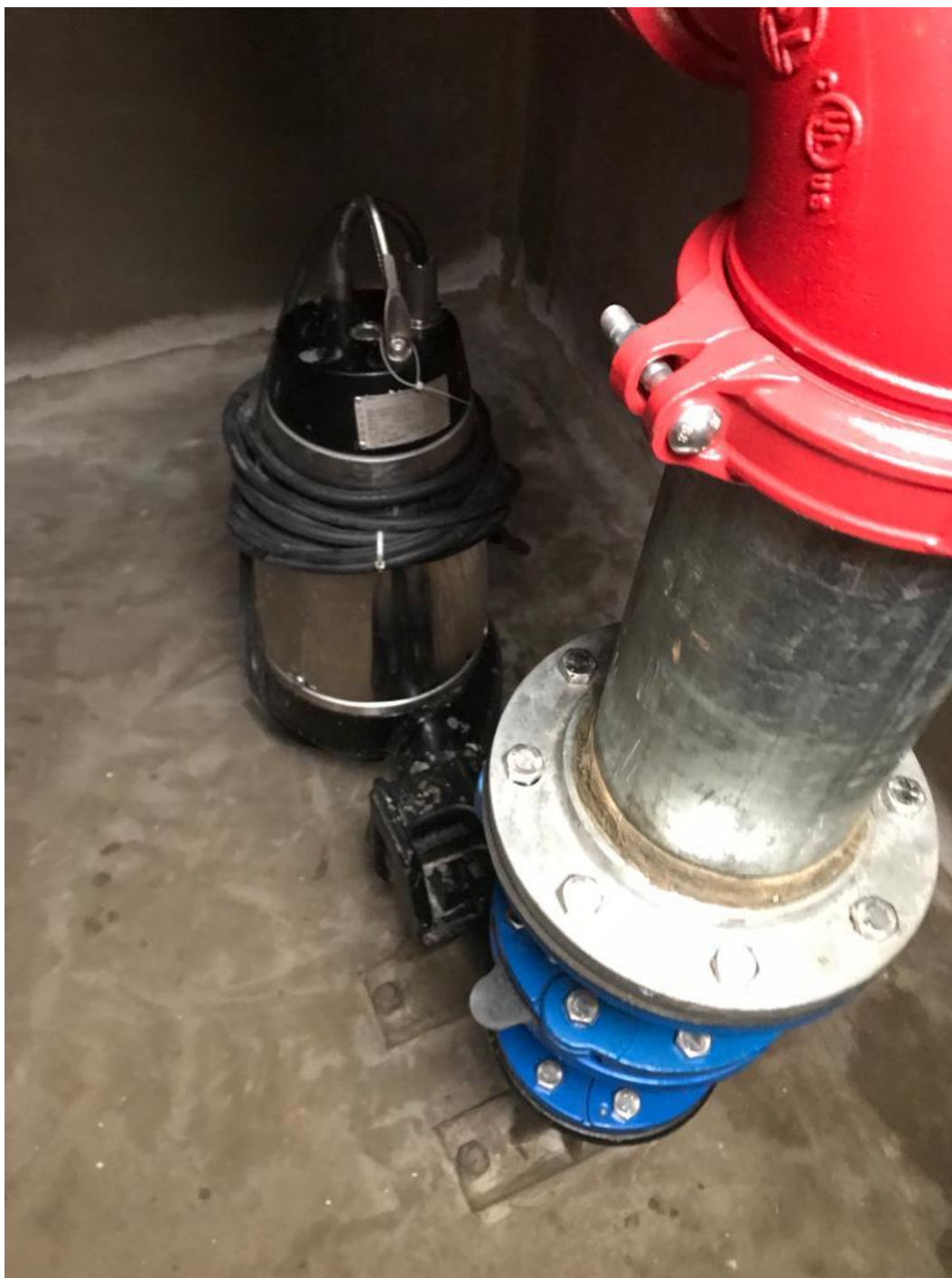
Figura A5.3-7: Fotografia de uma das Eletrobombas Submersíveis do Emissário da Higest Moçambique, Lda. (Fonte: O Autor, 2023)
