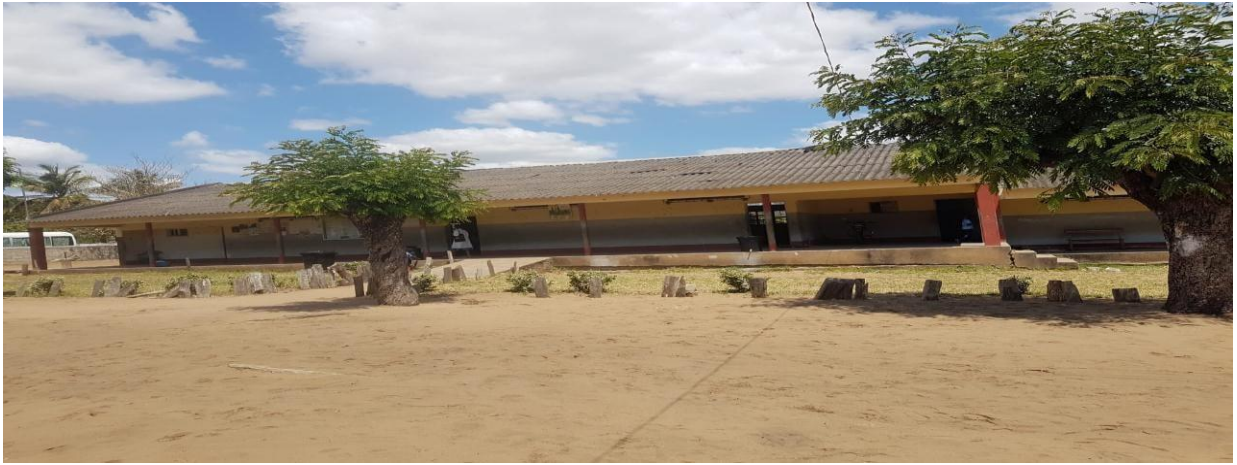
Figura 2 - Escola Primária Completa de Manjacaze
