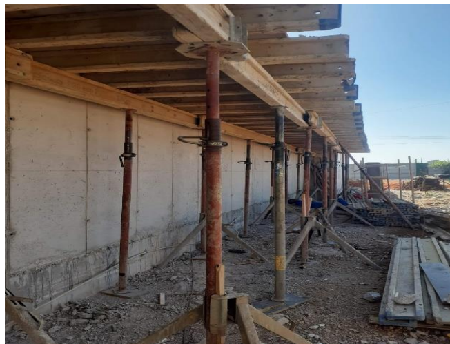
Figura: 29 Pranchas de madeira (fonte-autor) Figura: 30 Escoramento da cofragem da laje(fonte-autor)
