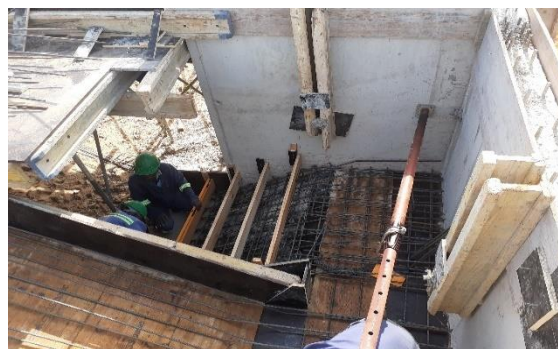
Figura: 37 Uso de nível na escada(fonte- autor)
