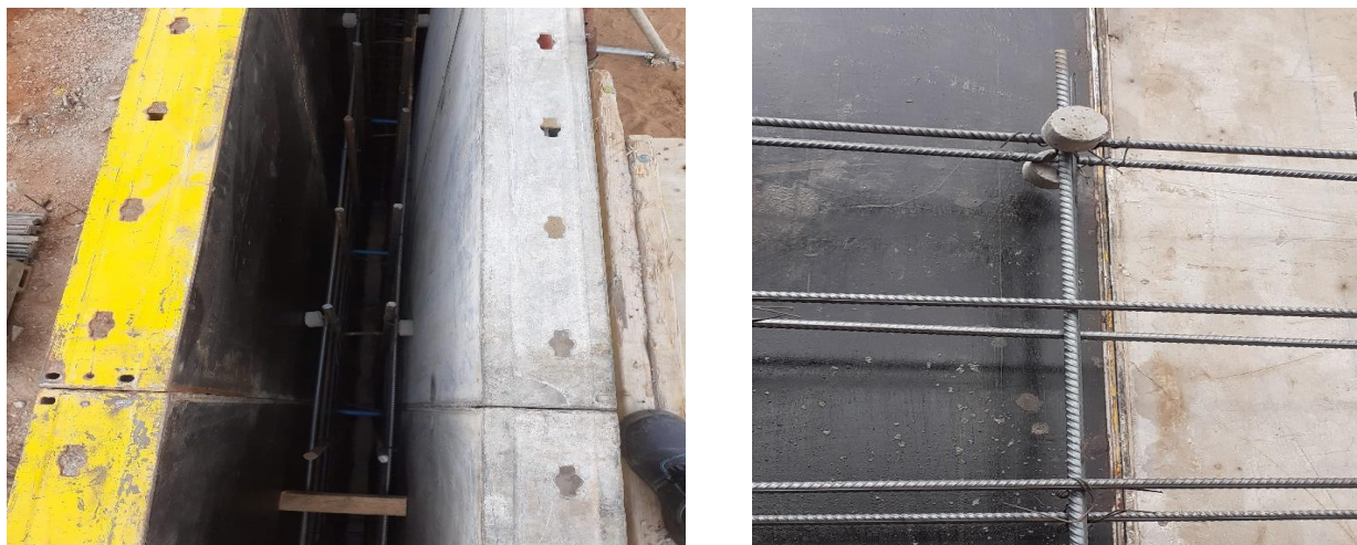
Figura: 17 Bloquetes de Betão para recobrimento (fonte-autor)
