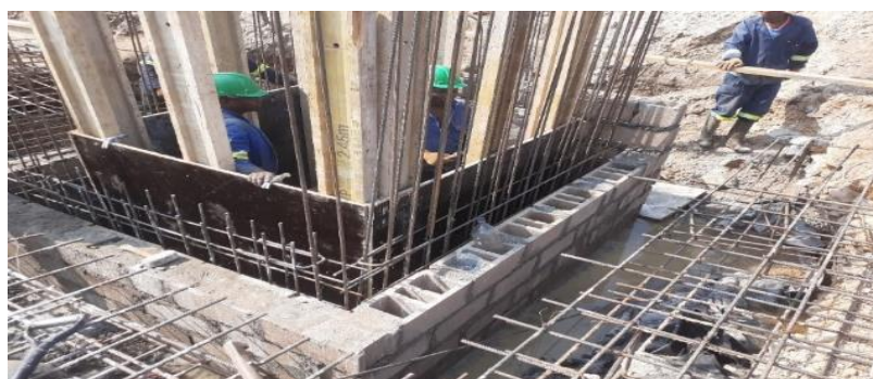
Figura: 27 Cofragem da caixa do elevador(fonte- autor)
