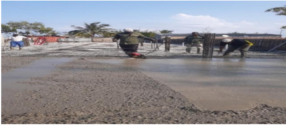
Figura: 14 Nivelamento usando régua de vibração(fonte- autor)
