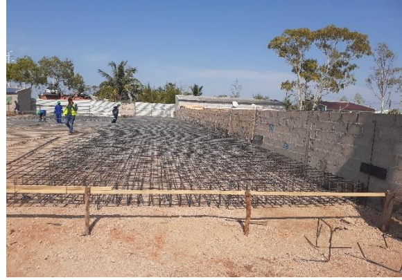
Figura: 9 Malha inferior e superior da laje de fundação com os respectivos cavalos(fonte- autor)
