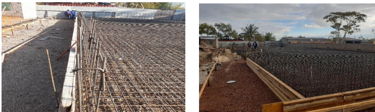
Figura: 12 Cofragem da laje da fundação(fonte- autor)
