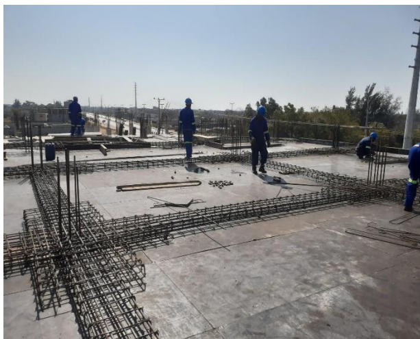
Figura: 31 Amarração da armadura da laje(fonte-autor)
