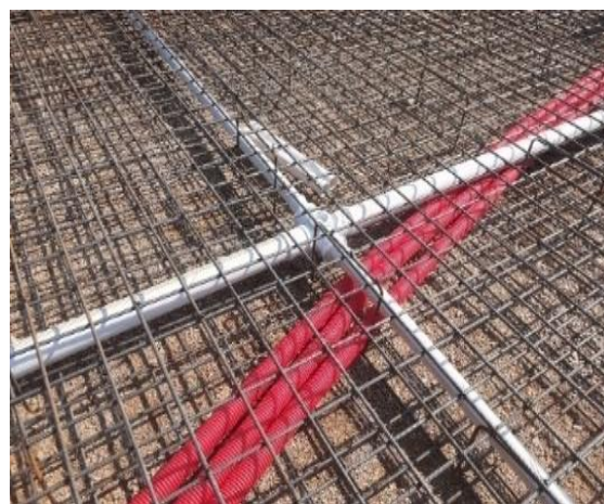
Figura: 46 Instalação da tubagem de drenagem
