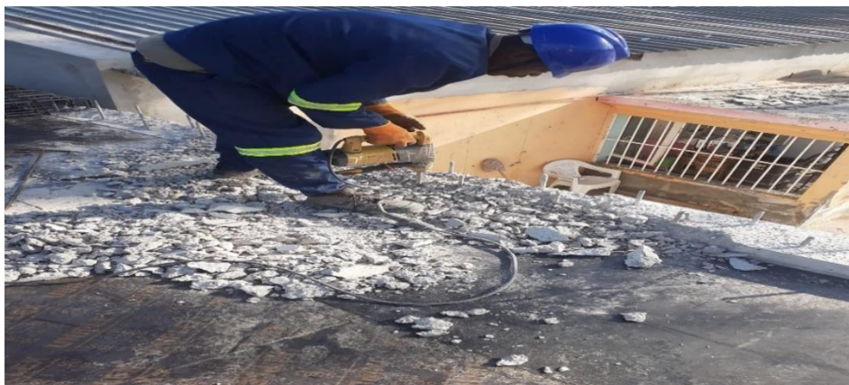
Figura: 20 Escarificação da base(fonte- autor)
