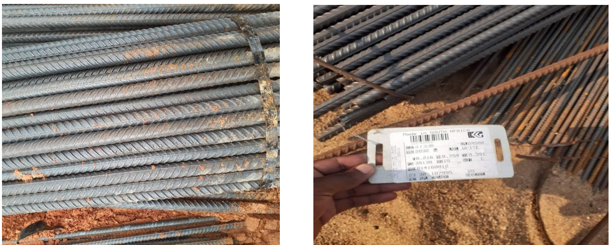
Figura: 44 Verificação e certificação das armaduras(fonte-autor)
