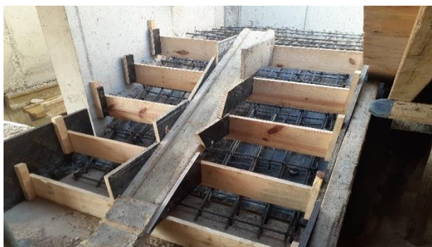
Figura: 36 Cofragem da escada(fonte- autor)
