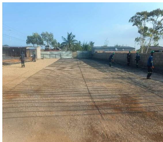
Figura: 8 Preparativos para início da amarração da armadura da laje de fundação(fonte- autor)
