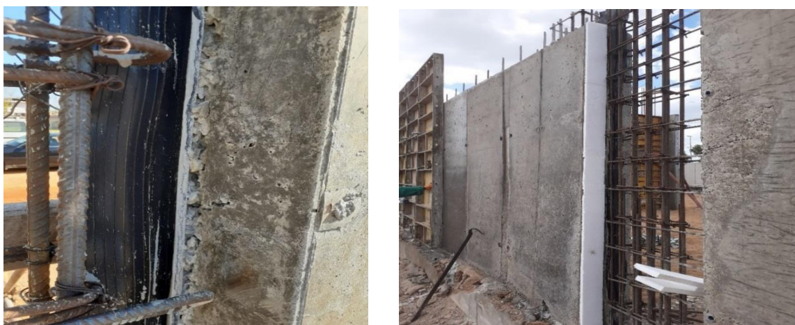
Figura: 21 Aplicação do esferovite e Water stop em uma junta de dilatação (fonte autor)
