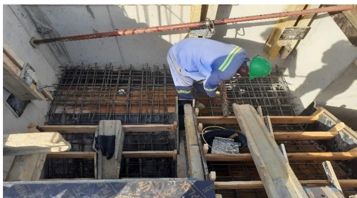
Figura: 38 Armadura das escadas(fonte-autor)
