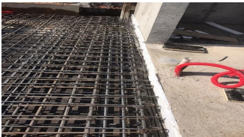
Figura: 32 Aplicação do esferovite e Water bar
