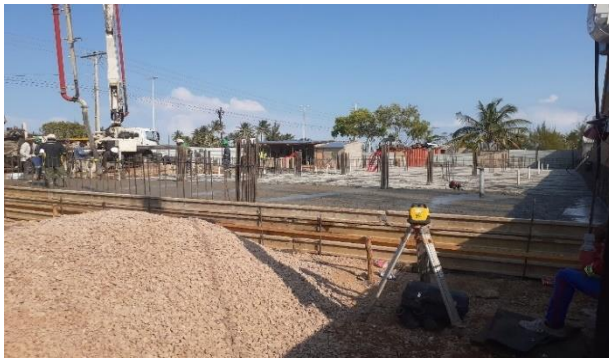
Figura: 15 Uso de nível a Laser para determinar a cota desejada(fonte- autor)
