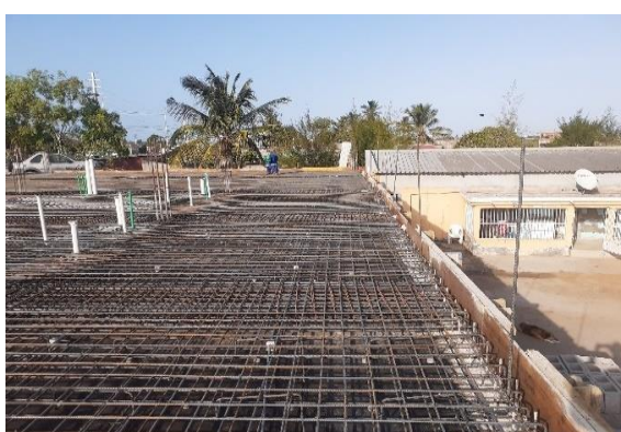
Figura: 34 Armadura da laje pronta para betonagem
