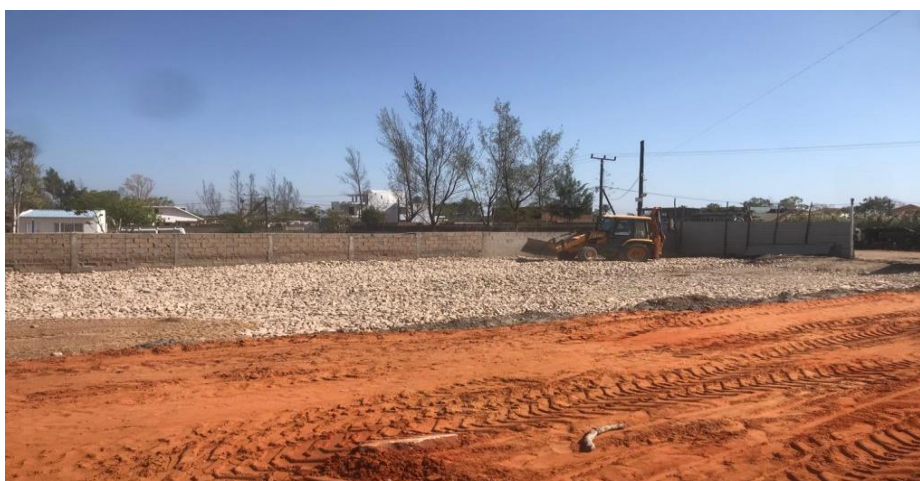
Figura: 4 Movimentação de terras e nivelamento da pedra do enrocamento(fonte autor)
