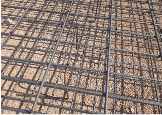
Figura: 9 Malha inferior e superior da laje de fundação com os respectivos cavalos(fonte- autor)
