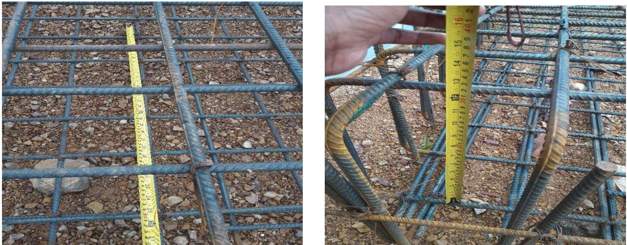
Figura: 43 Inspeção das armaduras fonte(autor)
