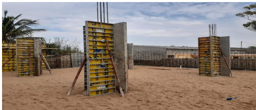
Figura: 18 Cofragem dos pilares (fonte-autor)
