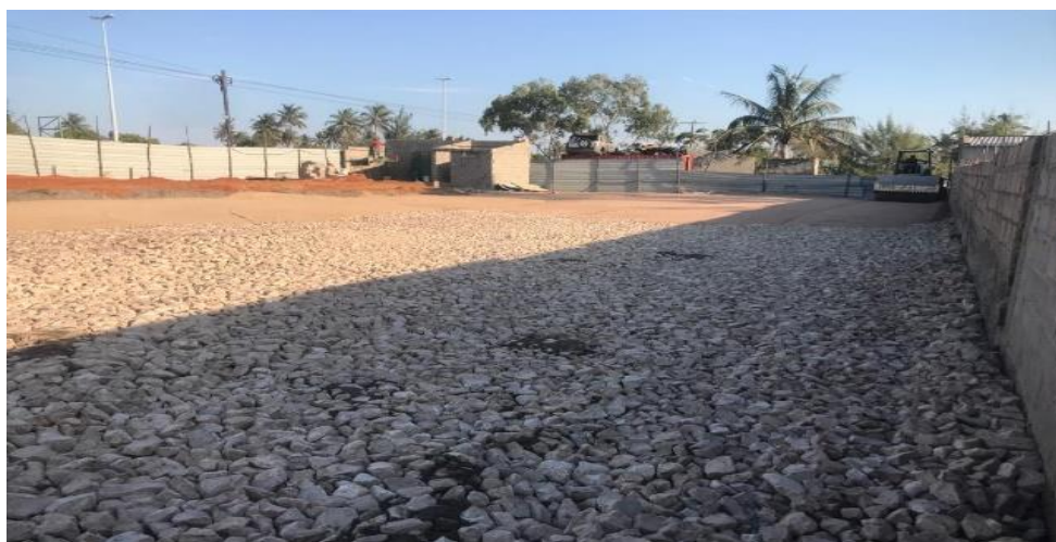
Figura: 6 Nivelamento do tout-venant(fonte- autor)
