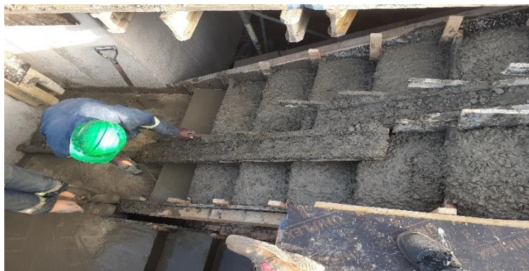
Figura: 39 Betonagem da escada(fonte-autor)
