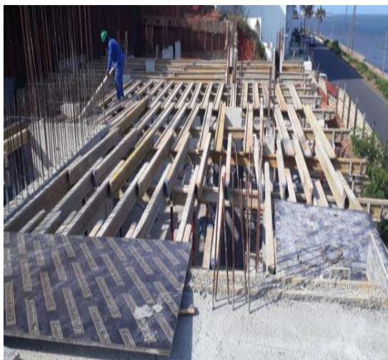
Figura: 29 Pranchas de madeira (fonte-autor) Figura: 30 Escoramento da cofragem da laje(fonte-autor)
