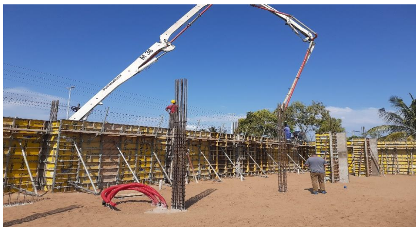
Figura: 23 Betonagem do muro de suporte(fonte-autor)
