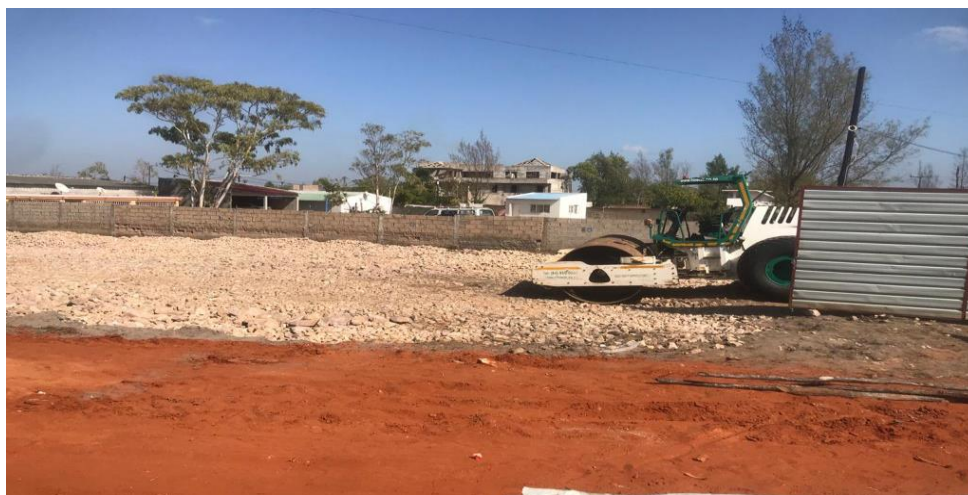
Figura: 5 Compactação da pedra de enrocamento(fonte- autor)
