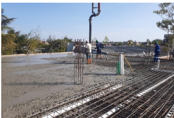
Figura: 33 Betonagem da laje(fonte-autor)
