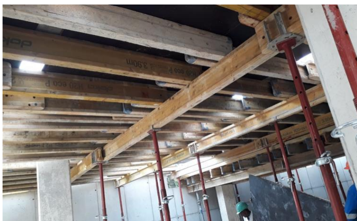
Figura: 28 Colocação dos prumos e vigas de madeira(fonte-autor)
