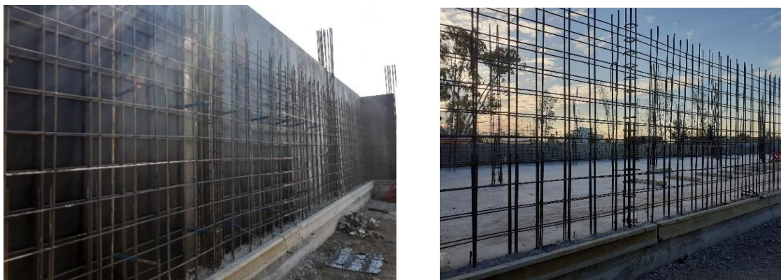
Figura: 19 Amarração da armadura e Cliques metálicos em "U"(fonte-autor)
