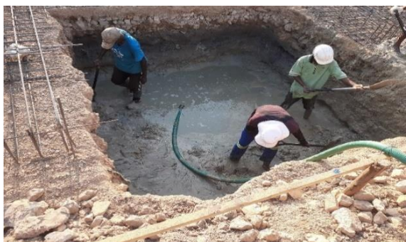
Figura: 25 Contenção área de trabalho(fonte-autor)
