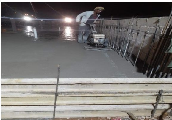
Figura: 16 Uso de helicópteros para afagamento mecânico do Betão(fonte- autor)
