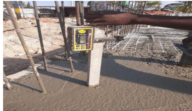
Figura: 15 Uso de nível a Laser para determinar a cota desejada(fonte- autor)
