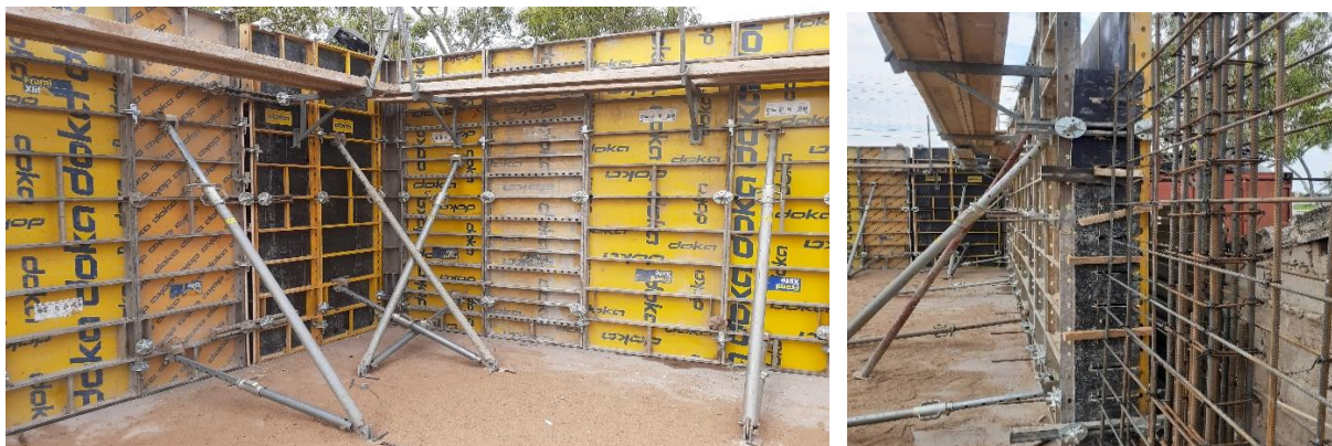
Figura: 22 Cofragem do muro devidamente escorada(fonte-autor)
