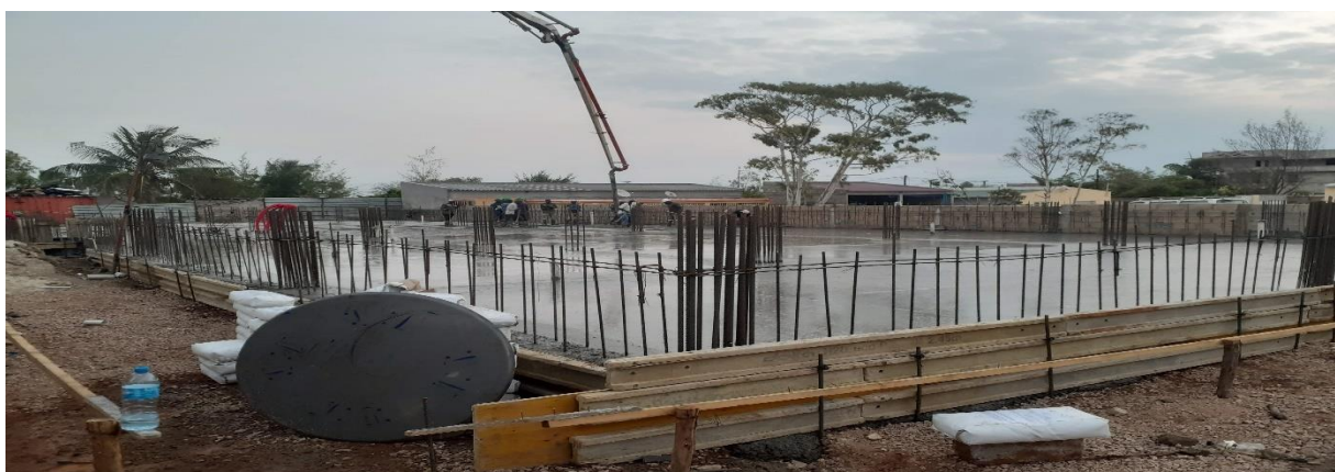
Figura: 13 Colocação e vibração de Betão(fonte- autor)
