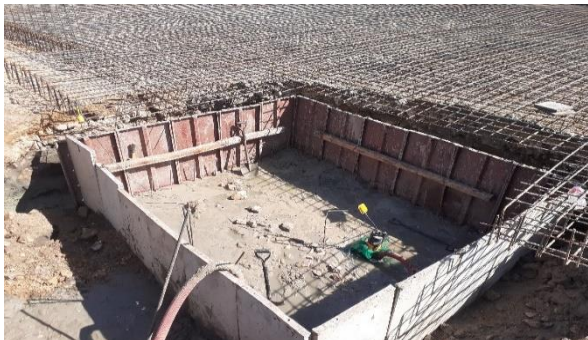
Figura: 26 Escavação da caixa do elevador
