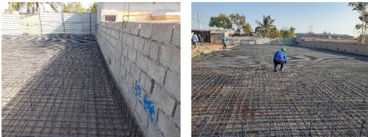
Figura: 11 Cavaletes espaçados a 1 m (fonte-autor)
