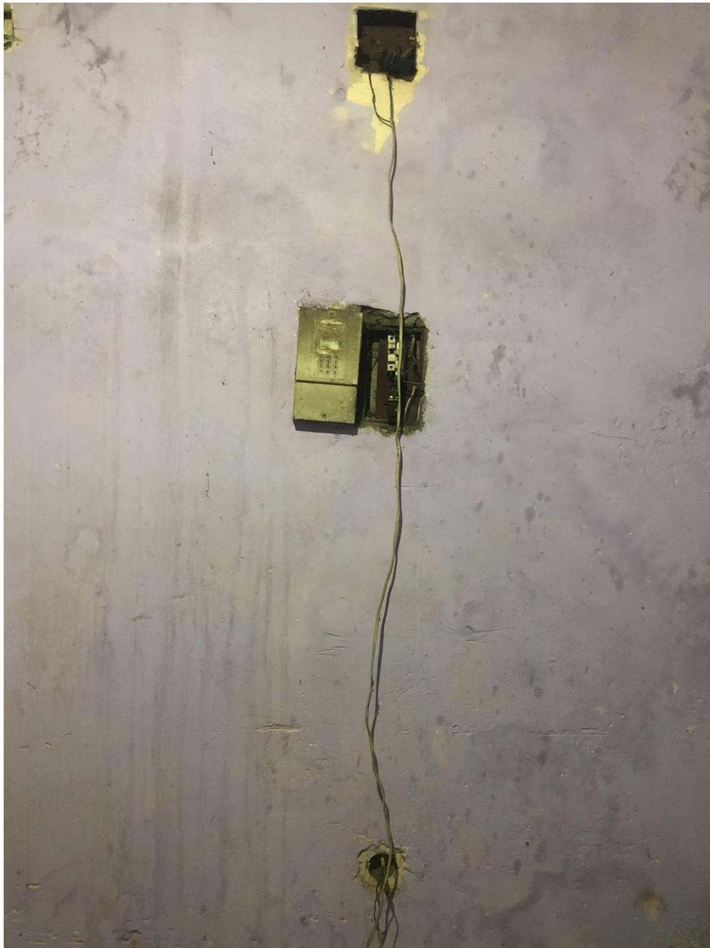
Figura Anexo7.7 instalação com furto de energia
