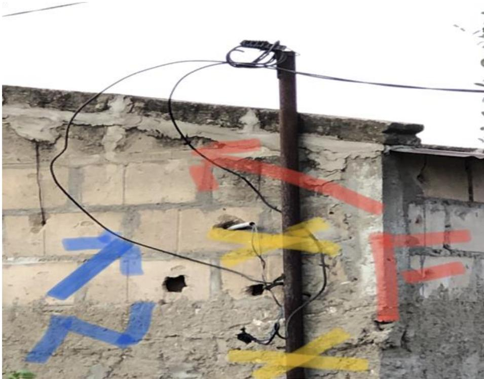
Figura 1 Instalação da Baixada de baixa tensão para uma residência com probabilidade de perdas de energia (Fonte: Autor)
