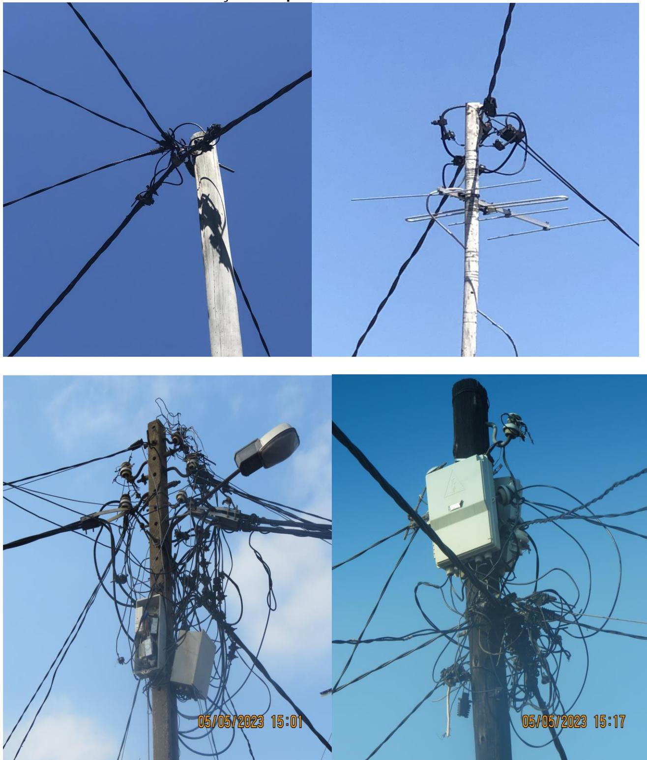
Figura Anexo 1.1 Redes de distribuição do tipo baixada sobre baixada
