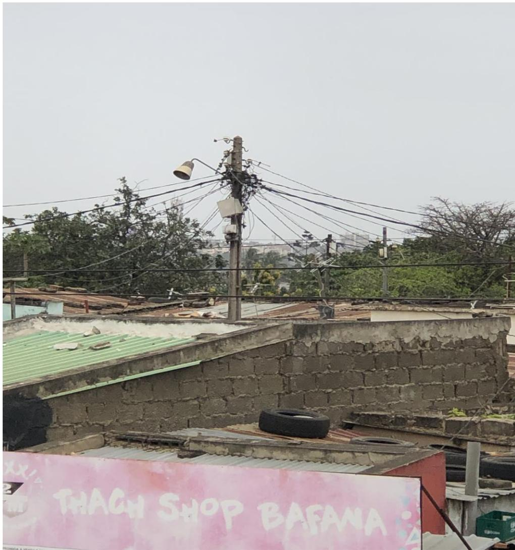
Figura Anexo 3.3 Rede de distribuição com excesso de ramais
