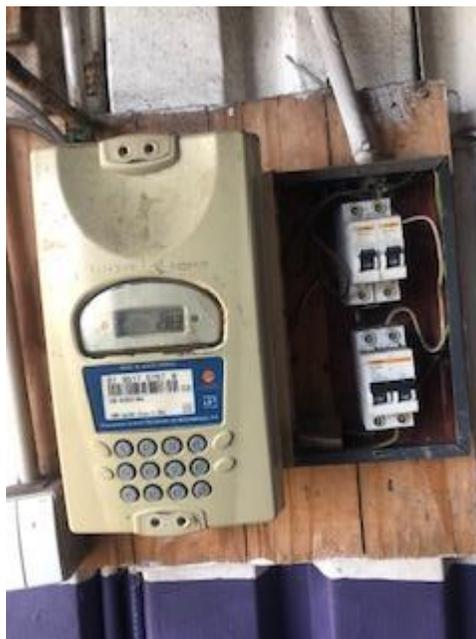
Figura Anexo 2.2 Tipo de contador integrado no interior da residência
