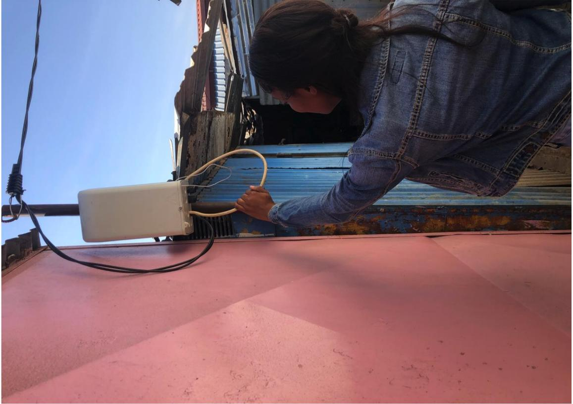
*Figura 7 Instalação de baixa tensão com uma altura de de 1,7 metros com probabilidade de perdas não-técnicas (Fonte: Autor)*
