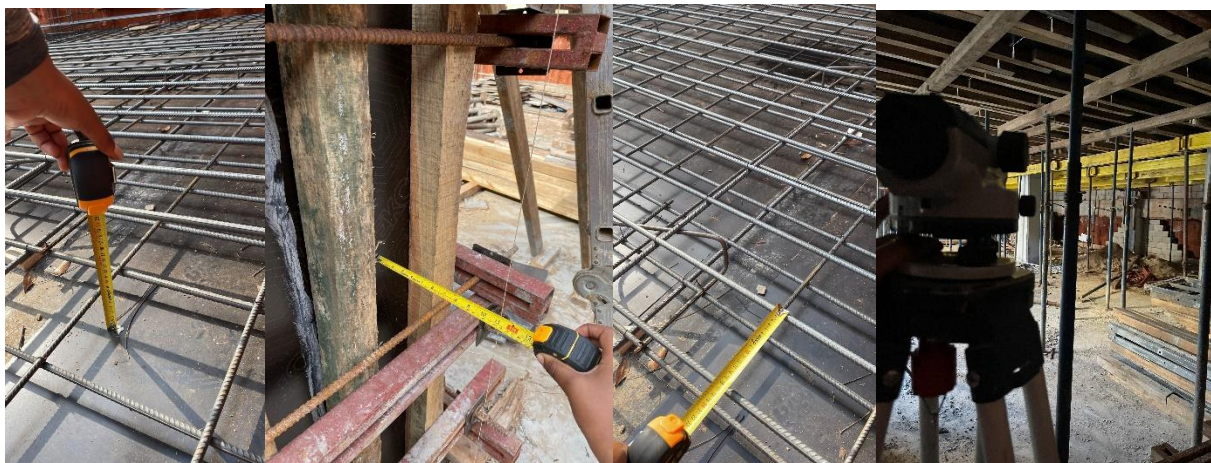
Figura 11: Verificação da espessura da laje, da verticalidade do pilar, do afastamento entre as armaduras da laje e escoramento com nível. (Fonte: Autora)
