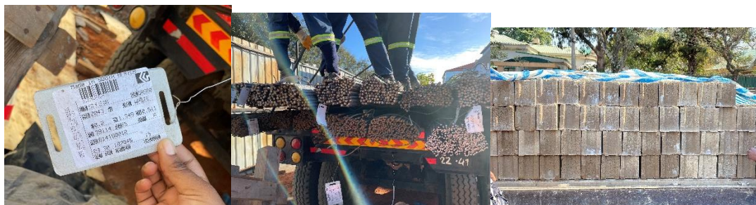
Figura 10: Recepção de material: varões e blocos de alvenaria. (Fonte: Autora)
