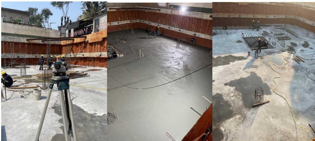
Figura 12: Verificação com recurso a nível, Acabamentos da betonagem e Pós betonagem
