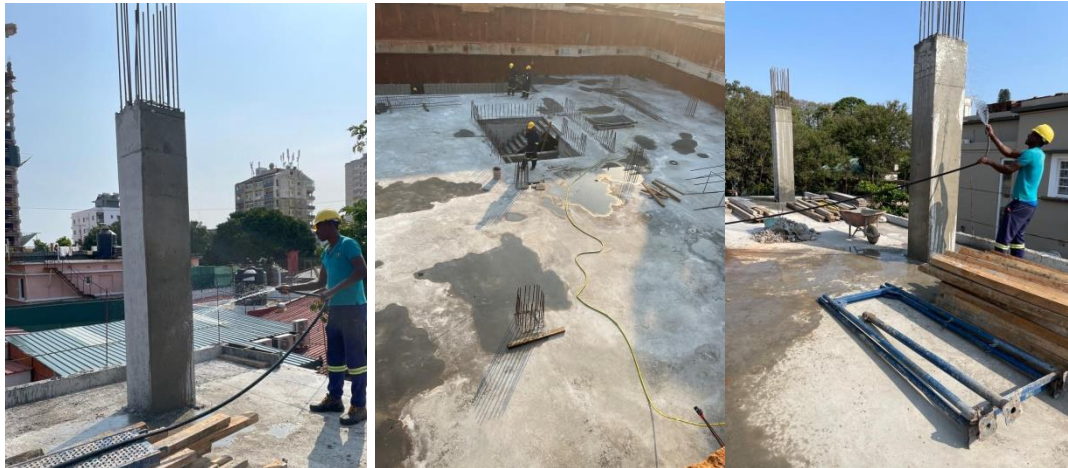
Figura 24: Cura por aspersão da laje e do Pilar
