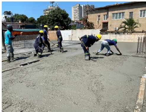
Figura 17: Betonagem da laje
