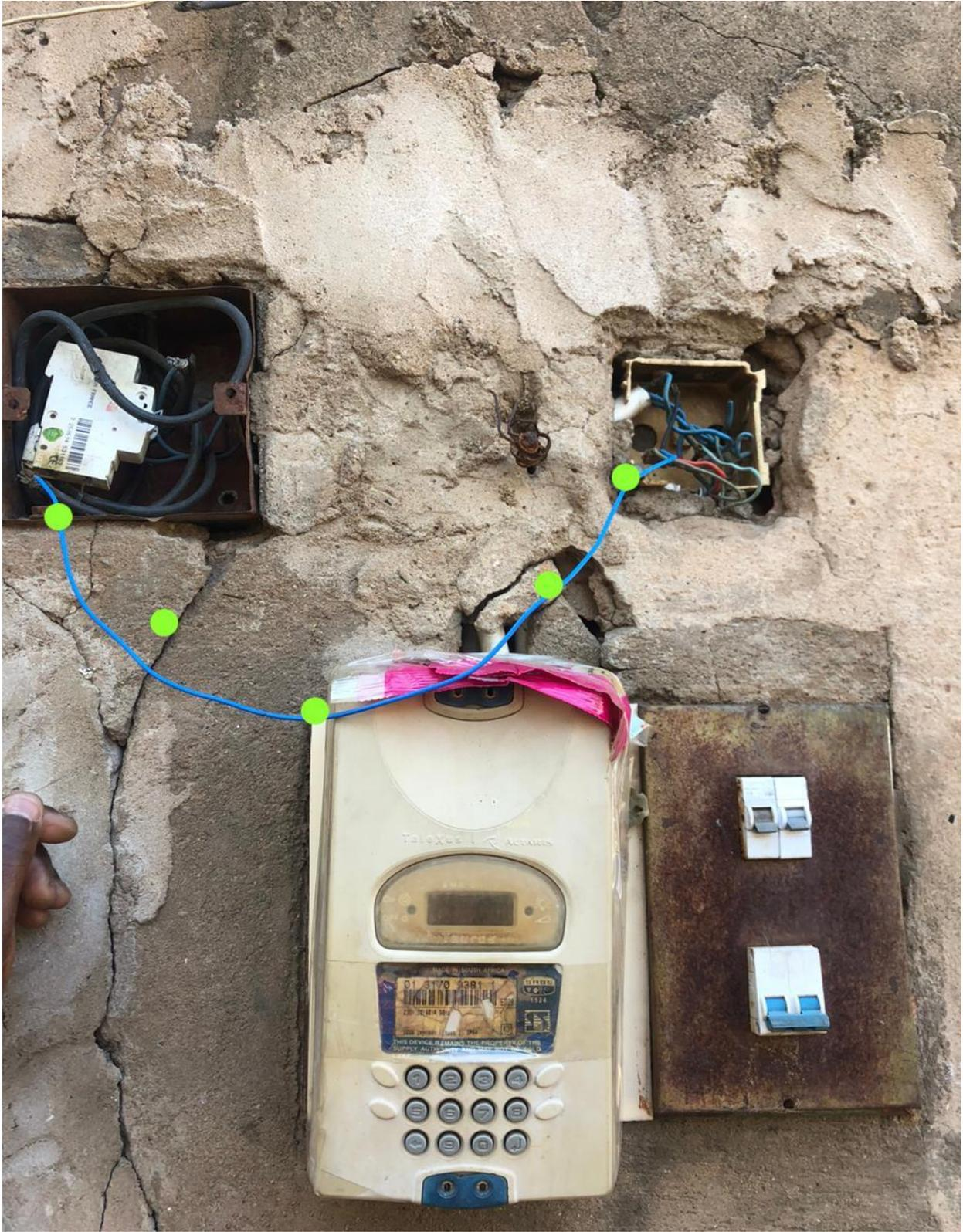
Figure 10: Derivação da caixa de coluna para a carga (Autor, 2023)..
