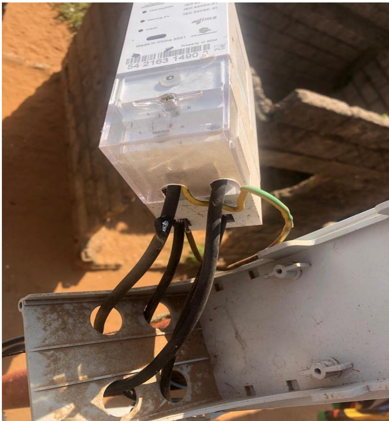
Figure 11: Ligação directa ou derivação no medidor (Autor,2023)..
