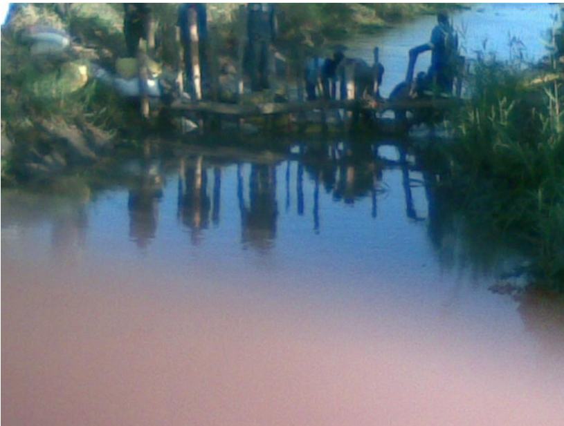
Imagem 2 – Montagem da barreira para contenção das águas da vala para a construção da comporta. (foto do dia 07/08/12).
