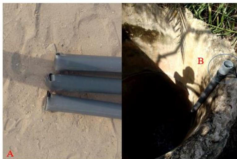
**Figura 45:** Tubo de PVC o: A. Filtro adaptado; B.Tampa;
