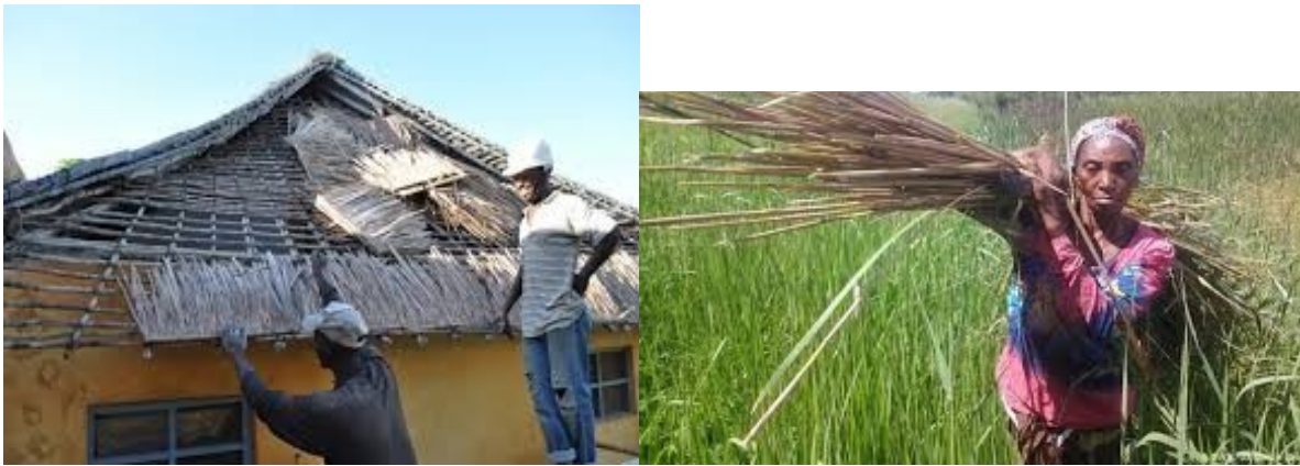
Figura 13 e Figura 14: revestimento da casa de dhaka . Figura 14. -Colheita de caniço, para a construção das paredes da casa de dhaka
