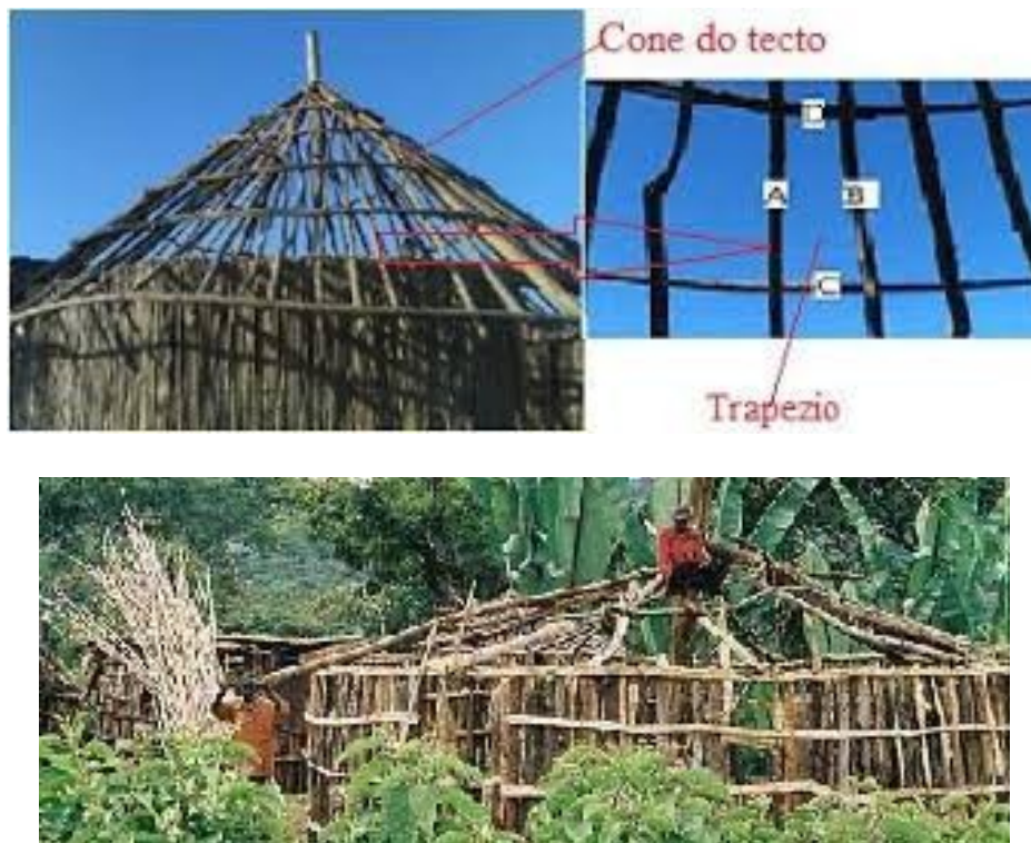
Figura 10, Figura 11 e Figura 12: esqueleto produzido de uma palhota.
