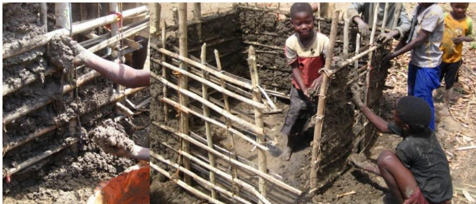
Figura 15 e Figura 16: Processo de maticar a casa com argila preta
