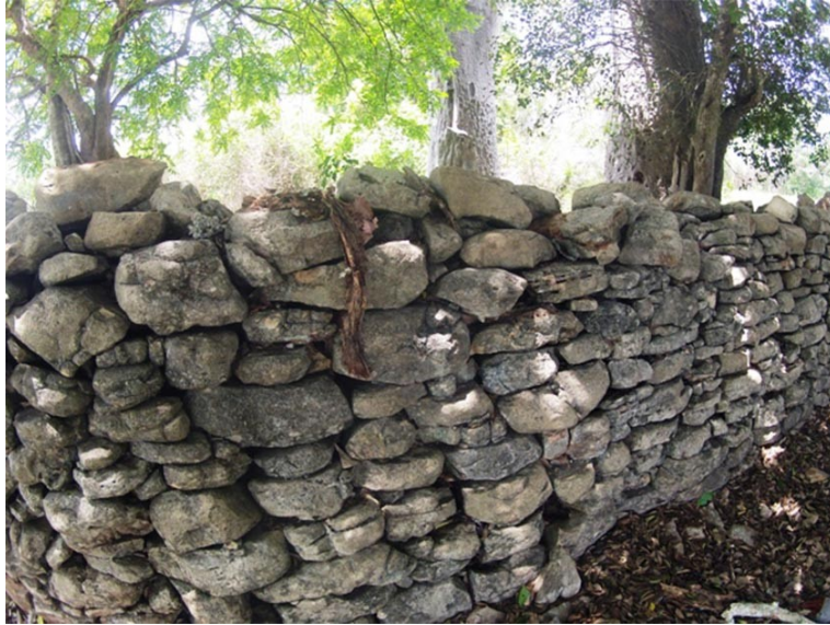
Figura 19: faixas irregulares de pedras na estação arqueológica de Manyikeni (foto: pela autora).
