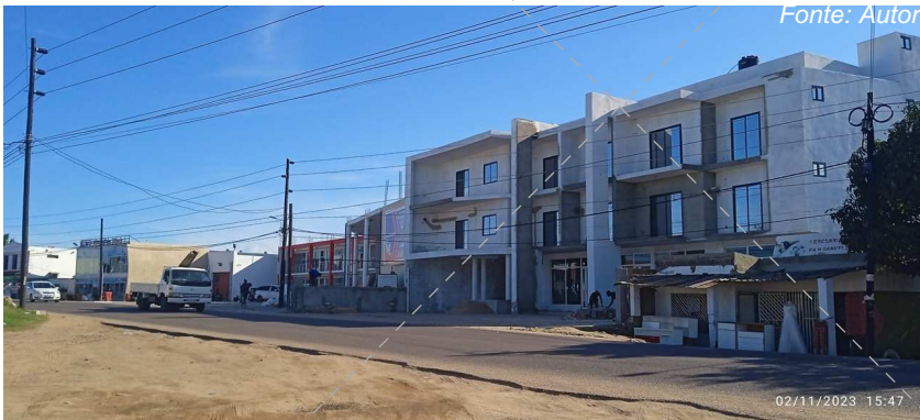
Imagem 60: Edifício Multifuncional – 4 pisos
