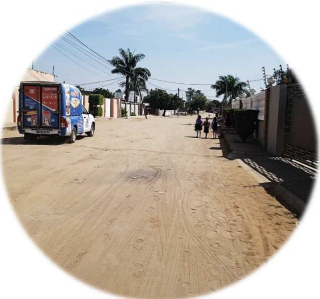
Imagem 90: Via interna com larguras adequadas para garantir a mobilidade e acessibilidade;
