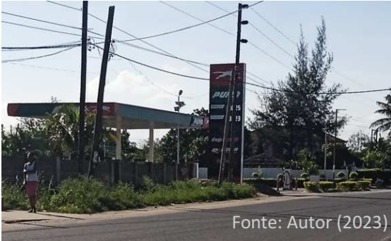
Imagem 67: Bombas de Combustível
