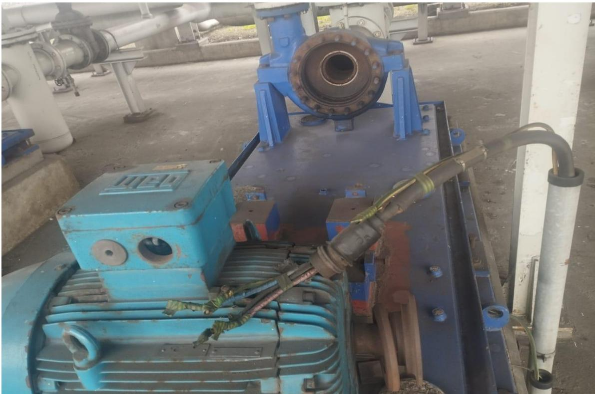
Figura 9. Problemas recorrentes de desgaste nas bombas de carreto, resultando em paradas frequentes para manutenção, Autor (2024)
