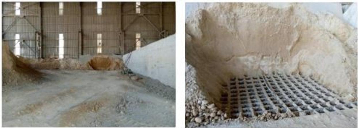
Figura 3. Hangar de Calcário e Tremonha do moinho (Limak, 2024)
