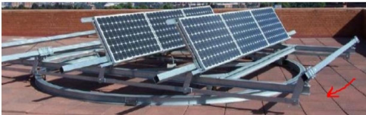
Fig. 11: Seguidor solar com estrutura de plataforma giratória
