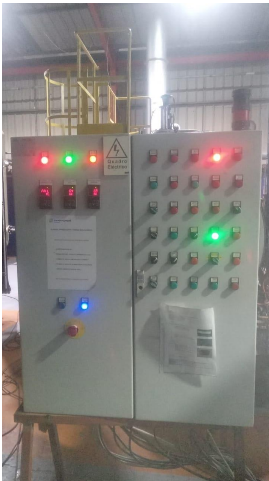
Figura 7: Quadro de comando da caldeira
