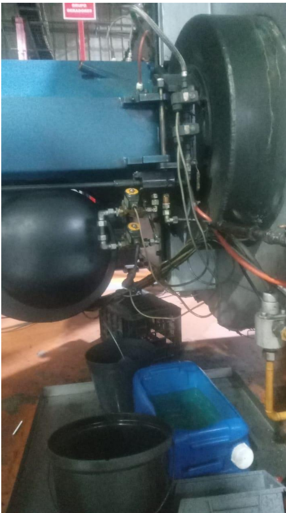
Figura 6: Fuga de diesel no modulador do queimador
