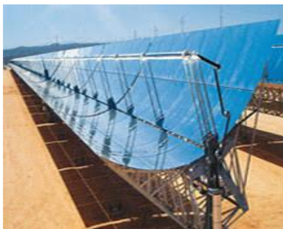
Fig. 2A Coletores Solares de Foco em Linha. Fonte: Energia Solar Fotovoltaica.b
