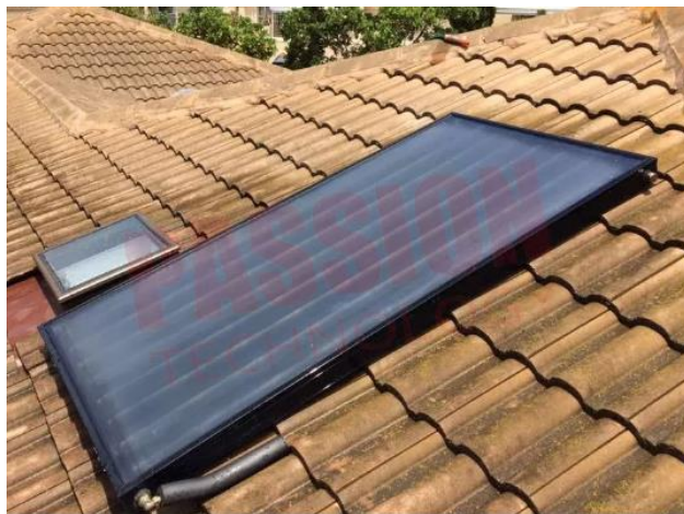
Fig. 1A Colector Solar de Placa Plana
