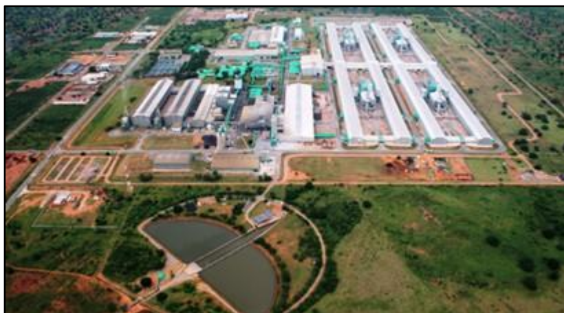
Figura 13 Planta da Moçambique Alumínio
