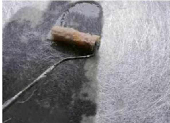
Figura 35: Aplicação de resina epóxi em manta de fibra
