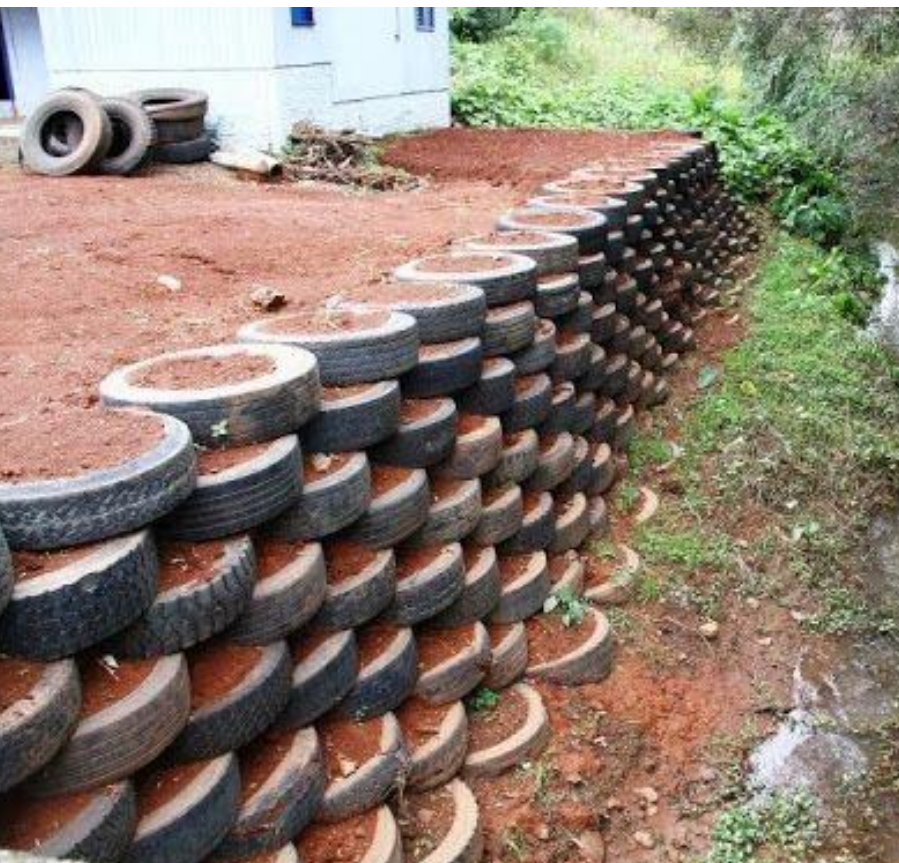
FIGURA 10: Murro de contenção de Pneus
