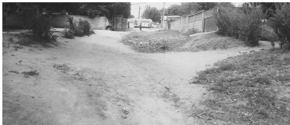
Fotografia.34 via degradada (escoamento do caudal)
