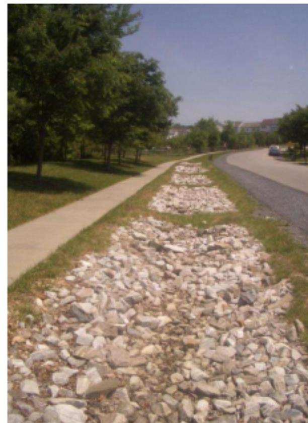
Figura.12 Integração de trincheira de infiltração (Sustainable Stormwater Management, 2007)
