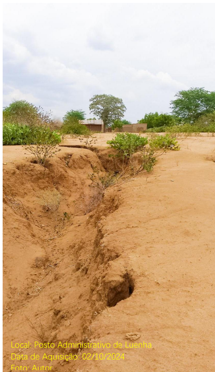
Erosão em Sulco/Ravinar
