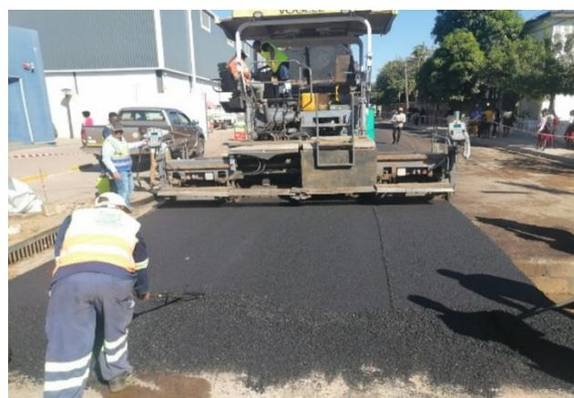
a) descarga do alcatrão quente na espalhadora; b) espalhando o alcatrão na via
