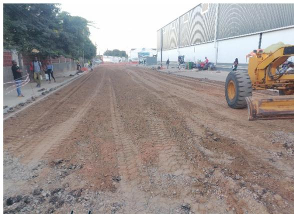
*Figura 21. limpeza e escarificação da via com recurso a niveladora*
