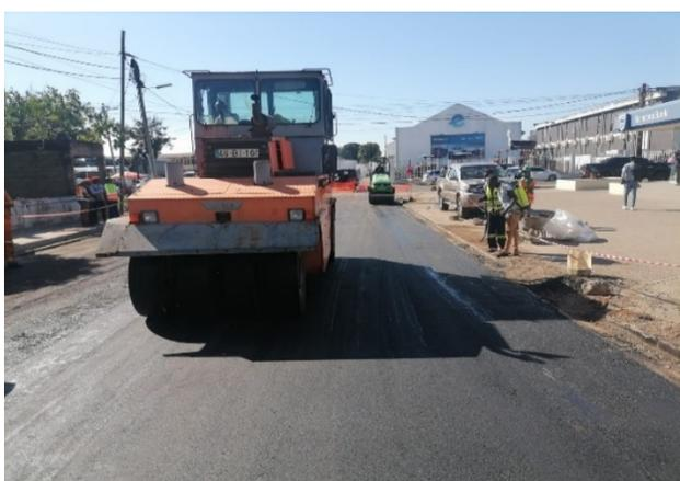
c) início da compactação com o cilindro compactador
