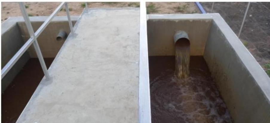
**Figura 3.4** Câmara de entrada – água bruta e caudal de retorno.
