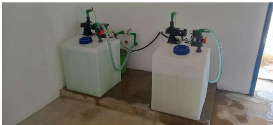
**Figura 3.5** Sala de preparação e dosagem de cloro e sulfato de alumínio (dois recipientes de 15 litros cada).
