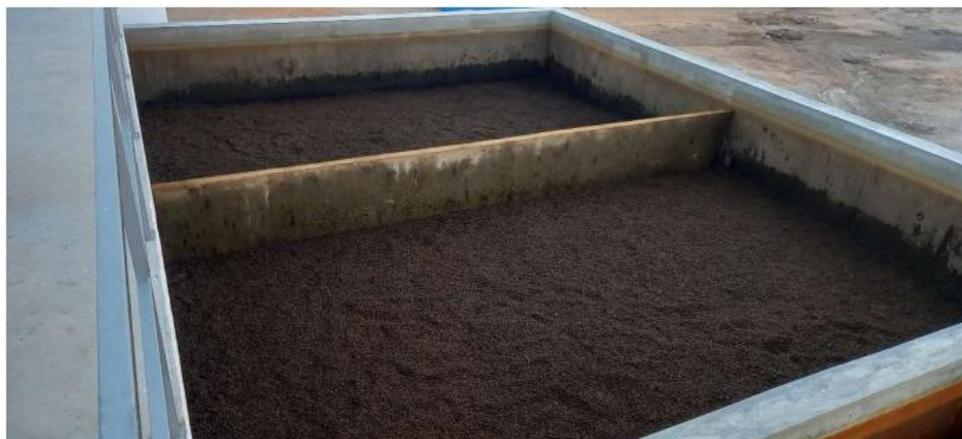
**Figura 5.2** Esvaziamento dos pré-filtros e limpeza por retrolavagem.
