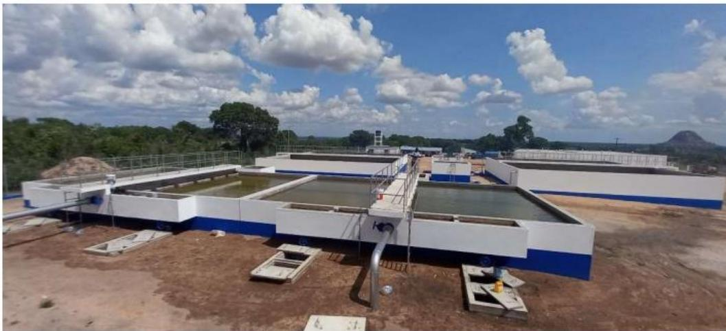
**Figura 3.6** Pré-filtros de fluxo ascendente – duas linhas de produção.
