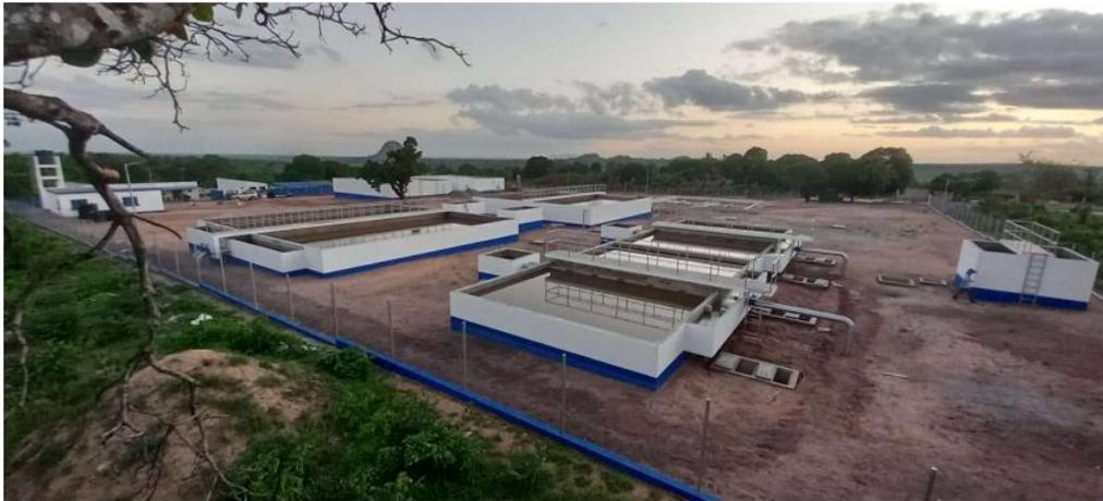
**Figura 3.3** Vista geral da ETA de Murrupula – câmara de entrada, pré-filtros e filtros lentos.
