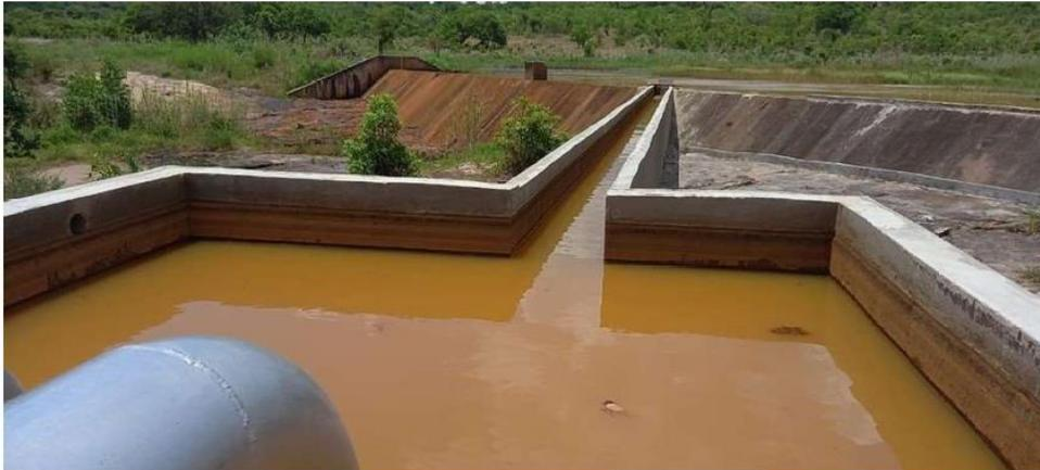
**Figura 4.2** Canal e poço de captação da estação de captação do SAA de Murrupula.
