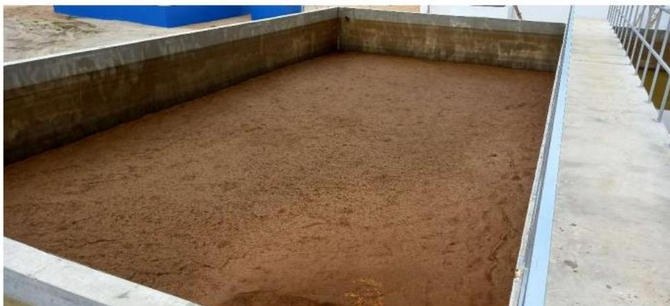
**Figura 5.4** Esvaziamento dos filtros lentos e remoção da lama do topo da areia fina importada.
