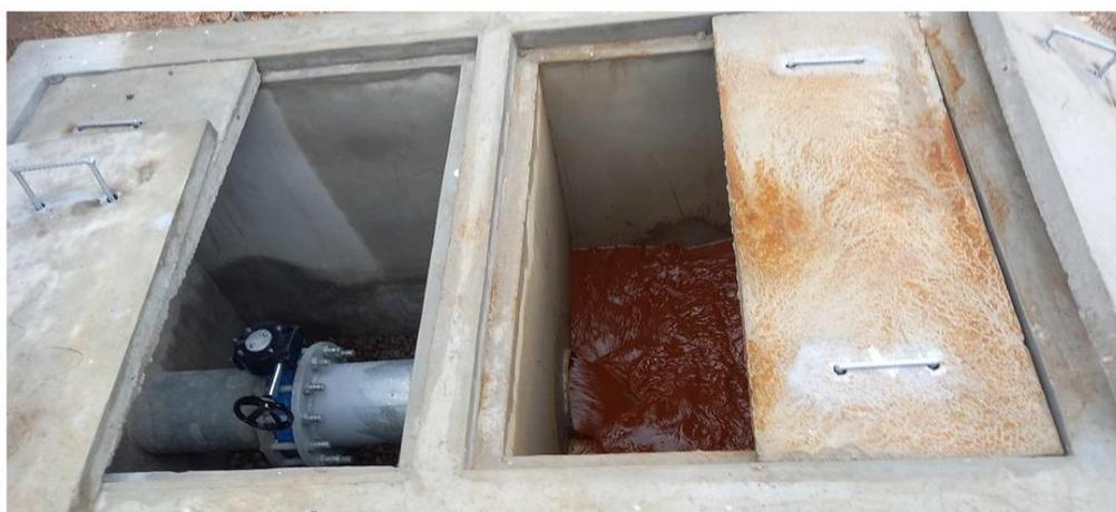
**Figura 5.3** Limpeza dos pré-filtros – descarga de água de purgas.
