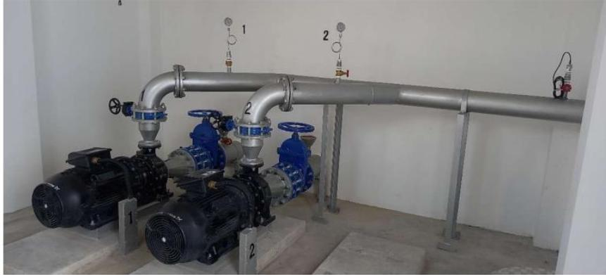
Figura 4.3 Estação de bombagem de água bruta: bombas adutoras, válvulas e manómetros.
