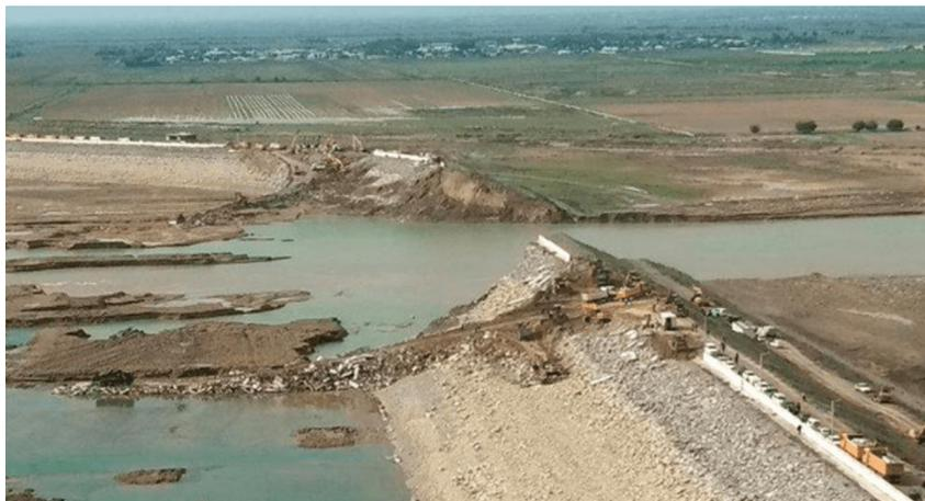
**Figura 2.2- Barragem de Sardoba após a rotura.**
