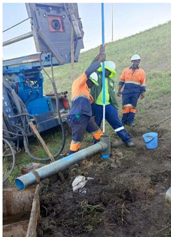
Figura 3.8 - Instalação dos Piezómetros nos furos.
