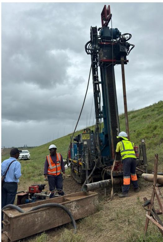
Figura 3.7 - Execução dos furos para instalação dos piezómetros.
