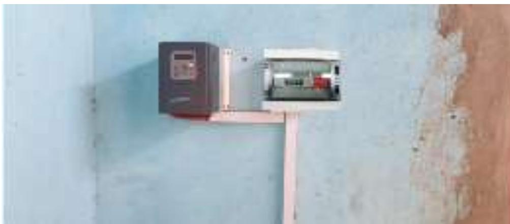
*Figure 39: ligações do quadro de acionamento da bomba.*
