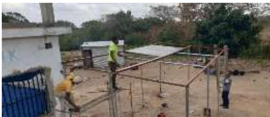
*Figure 36: colocação dos primeiros painéis solares na base.*
