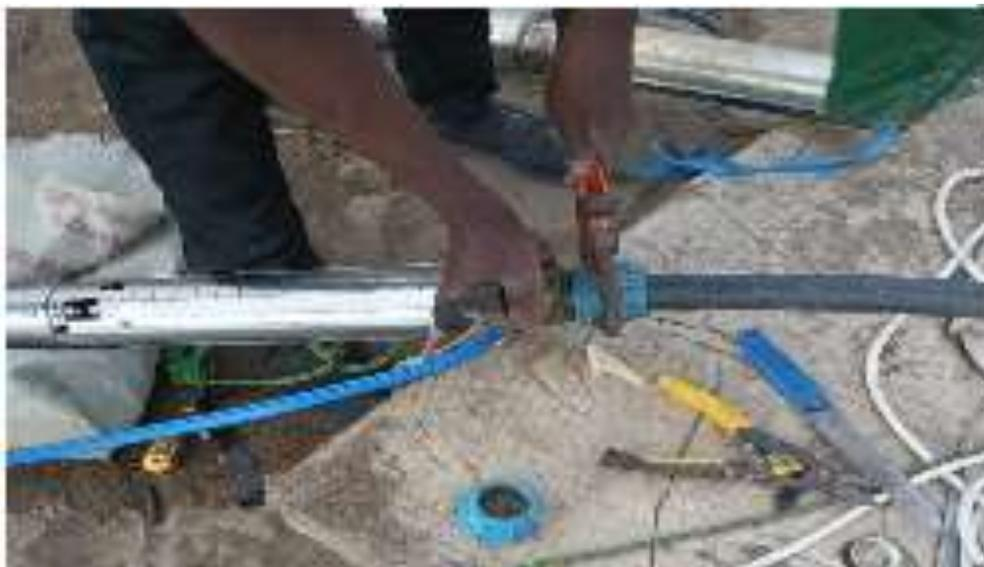
Figure 42: ligações do tubo de sucção da bomba.
