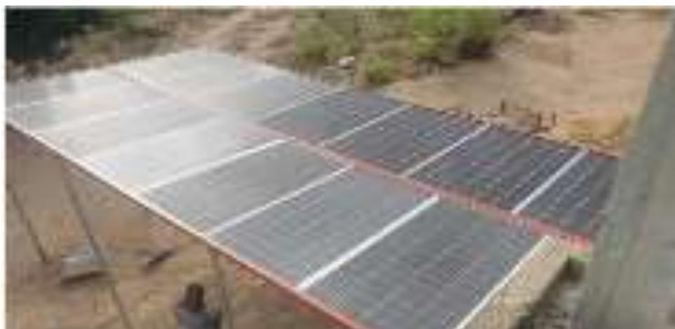
*Figure 37: :Colocação de todos os paines solares na base.*
