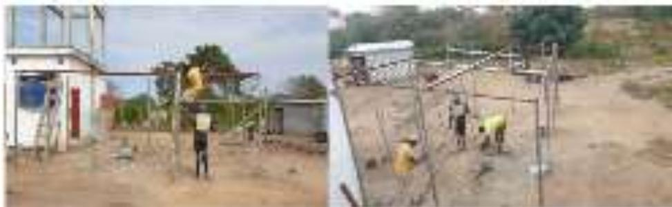
*Figure 35: colocação e soldagem da base de assentamento dos painéis solares nos suportes.*
