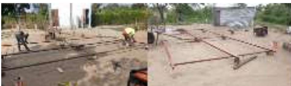
*Figure 34:pintura da base de assentamento dos painéis solares para resistência a corrosão.*
