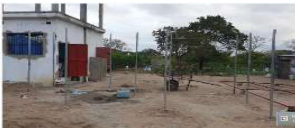
*Figure 33:Fim da montagem dos pilares.*
