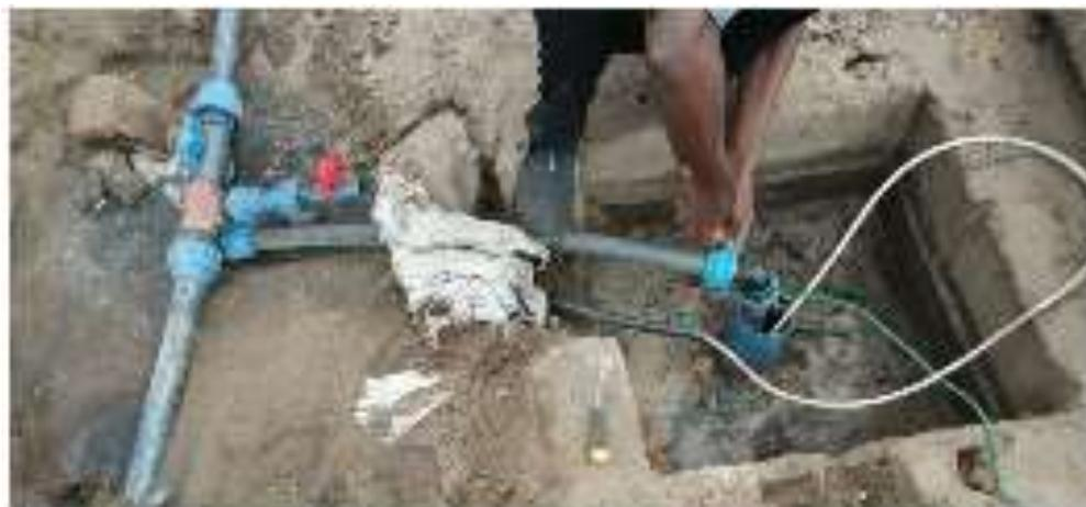
*Figure 45: ligações do tubo de sucção da bomba no sistema.*
