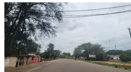
RUA B 77 PAVIMENTADA
