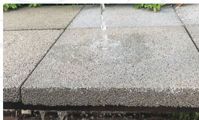
Pavimento poroso (áreas de estacionamento)
