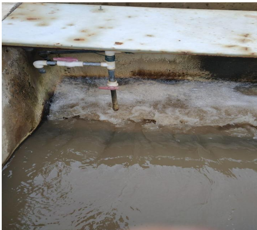
Figura 8: Ponto de doseamento do coagulante (sulfato de alumínio) na câmara de mistura.
