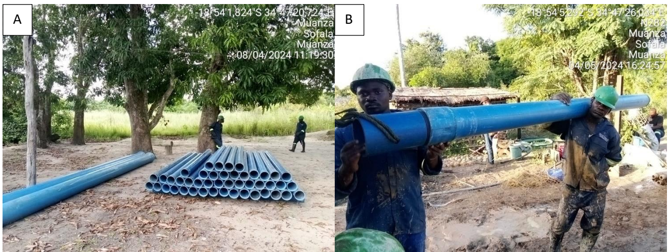
Figura 52: Tubos de Revestimento PVC 165mm, classe 16 de fundo roscado (A), Processo de Revestimento dos furos (B). Fonte: Autor
