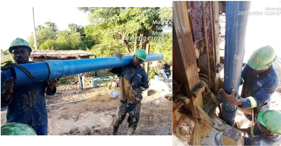
Figura 53: Filtros usados no revestimento dos furos construídos (Fonte: Autor)
