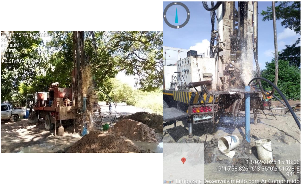
Figura 54: Limpeza e Desenvolvimento dos furos, usando o Método de Air-Lift (Fonte: Autor)
