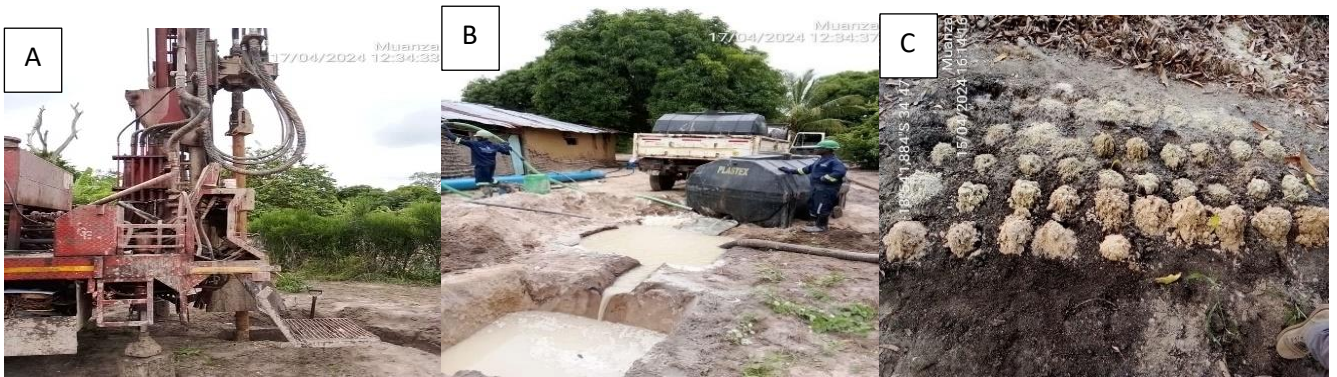
Figura 51: Sonda de Perfuração (A), Covas de Lama (B), Amostras Litológicas (C). Processo de Perfuração para os Furos de Captação (Fonte: Autor)
