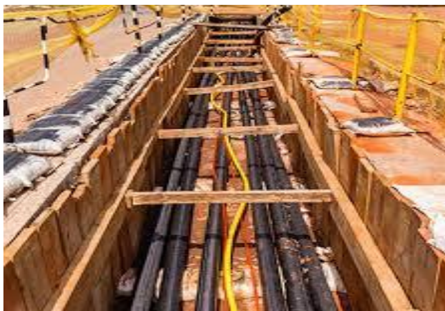
Figura 2: Condutores enterrados em vala
